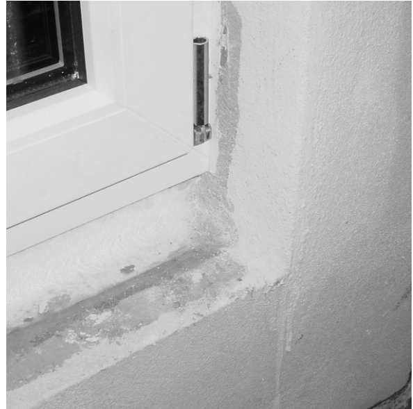
Bilder 5 und 6 Detailausschnitt unterer Eckbereich raumseitiger Anschluss vor und nach Leibungsputz.
