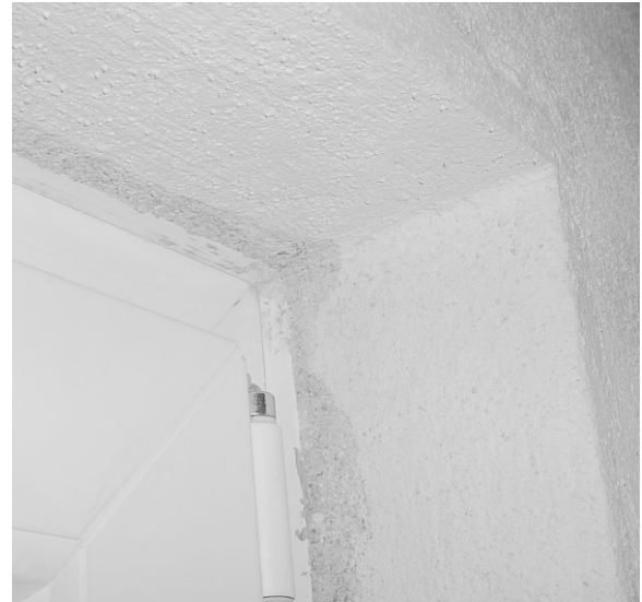
Bilder 1 und 2 Detailausschnitt obere Eckausbildung raumseitiger Anschluss vor und nach dem Leibungsputz
