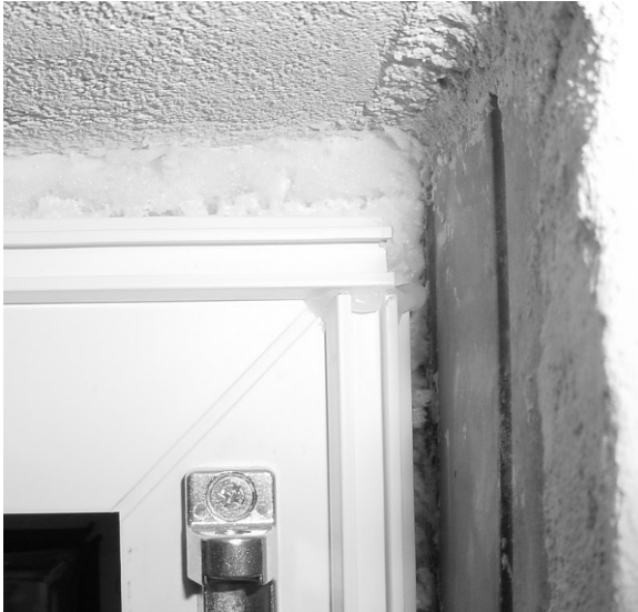
Bilder 1 und 2 Detailausschnitt obere Eckausbildung raumseitiger Anschluss vor und nach dem Leibungsputz
