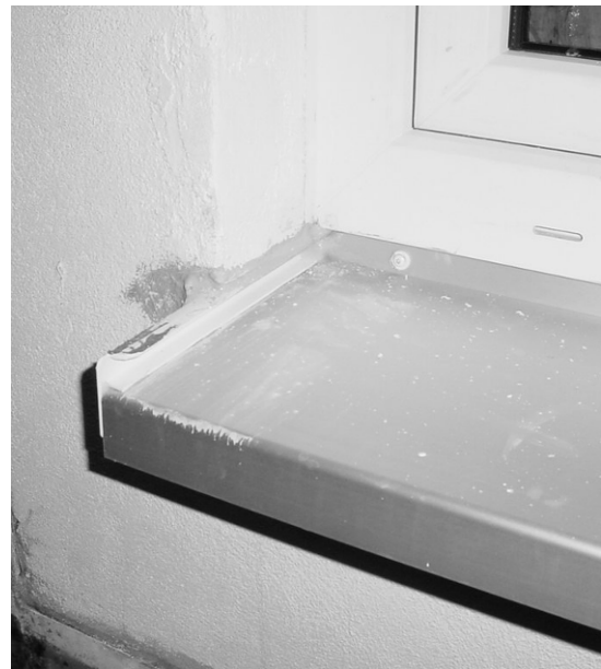
Bilder 7 und 8 Detailausschnitt unterer Eckbereich ohne und mit Aluminiumfensterbank.
