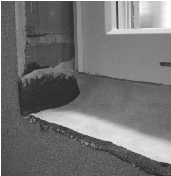
Bilder 7 und 8 Detailausschnitt unterer Eckbereich ohne und mit Aluminiumfensterbank.
