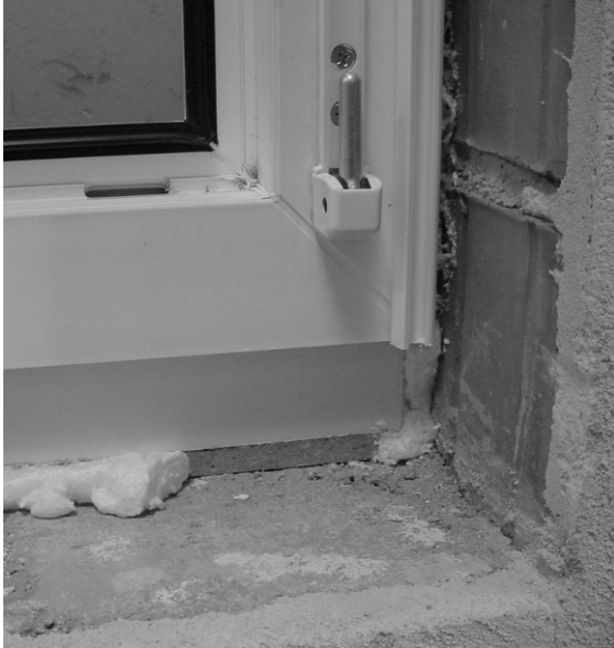
Bilder 5 und 6 Detailausschnitt unterer Eckbereich raumseitiger Anschluss vor und nach Leibungsputz.
