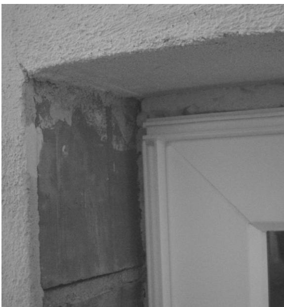
Bilder 3 und 4 Detailausschnitt obere Eckausbildung außenseitiger Anschluss vor und nach dem Leibungsputz.
