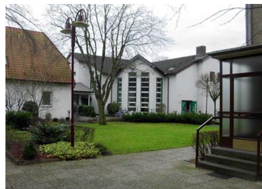
Das neue Pfarrheim 2002. Links das modernisierte Pfarrhaus von 1952.
