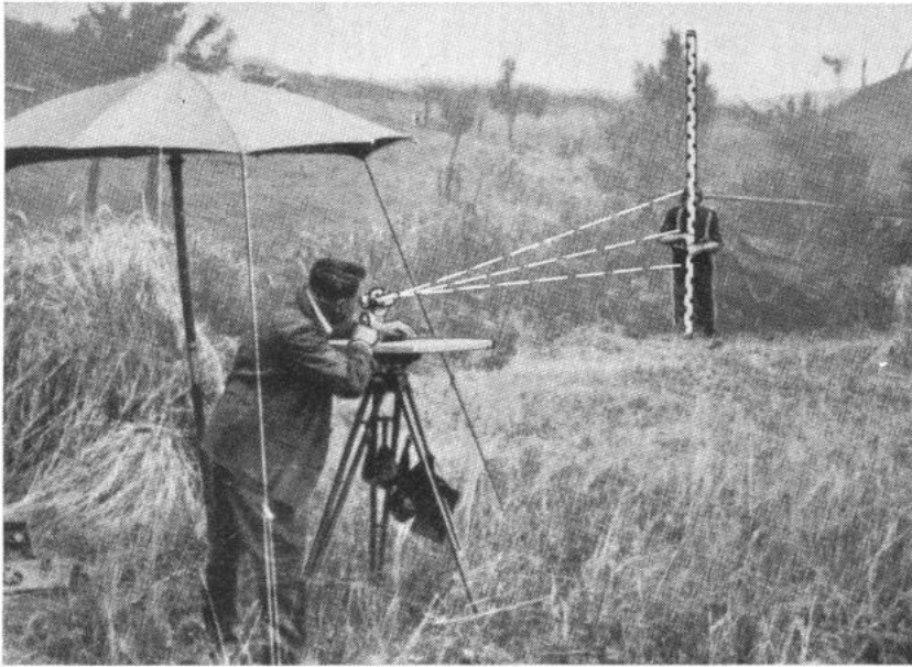
Abb. 3: Gelände- aufnahme mit Meßtisch und Kippregel
