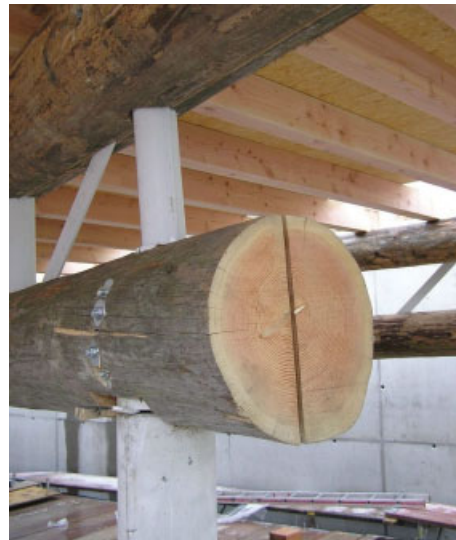
Bild 5. Rundholzträger aus Douglasienholz für den Hörsaal einer Fachhochschule, (das Kernholz ist deutlich durch die dunklere Färbung erkennbar) Fig. 5. Beam of round timber from Douglas fir
