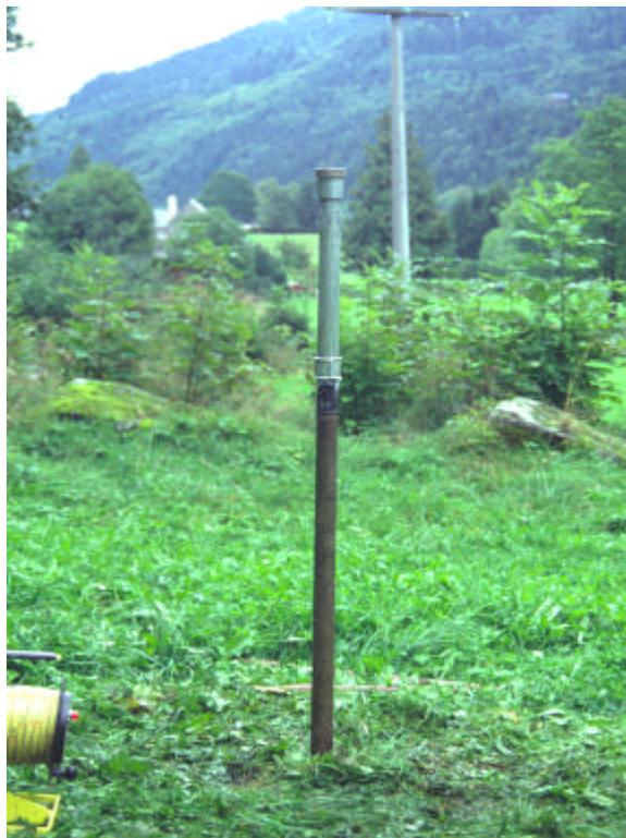
Abb. 3.3: Rammfilterbrunnen mit Schlagkopfaufsatz kurz von dem Einbau
