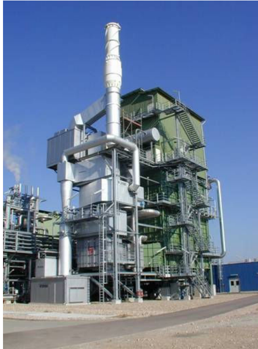
Abb. 11: Linde-Erdgas-Dampfreformer mit CO-Konvertierung, Gasreinigung per Druckschwingabsorption (PSA), Kapazität: H 2 35.000 Nm 3 /h, Reinheit: 99,99 mol-%
