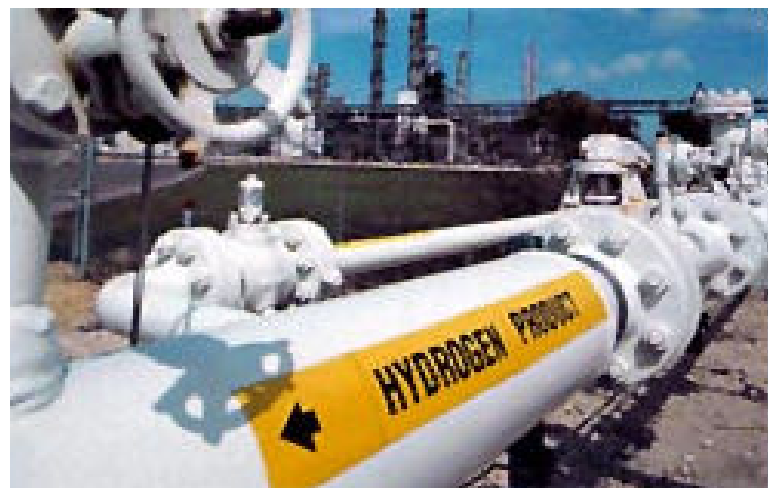
Abb. 40: Wasserstoff-Pipeline
