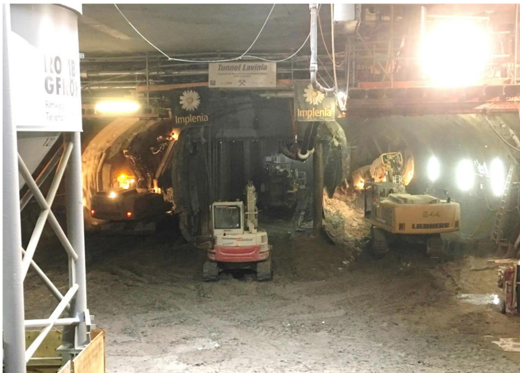
Abb. 13: Vortrieb der Bahnsteighalle im gefrorenen Boden unter dem Spreekanal
