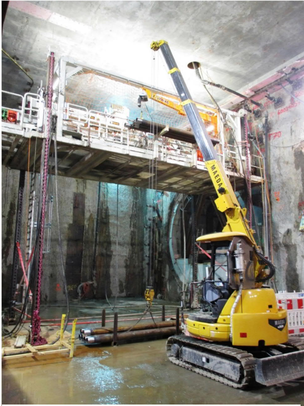
Abb. 9: Bohrgerät im Einsatz
