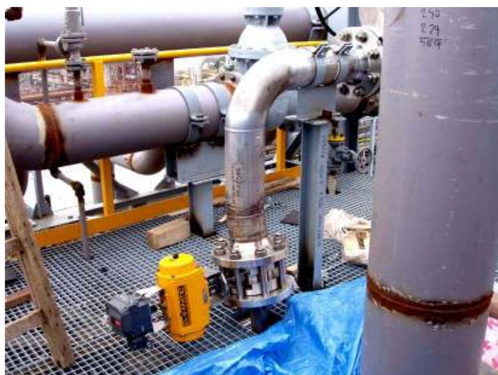
Bild 18: Entspannungsarmatur
