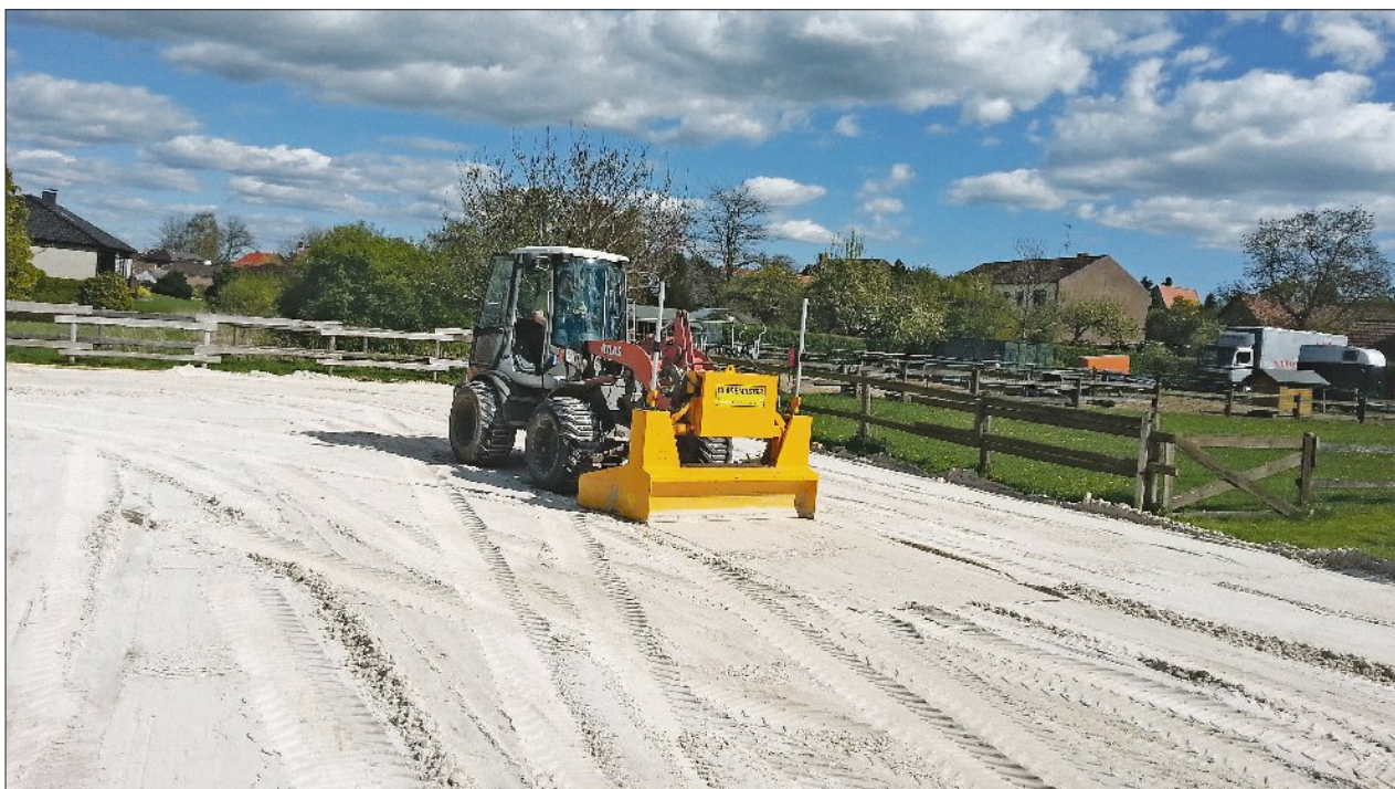
Wer die Technik hat, ist im Vorteil: Spezialisierte Sportplatzbauer besitzen moderne Geräte wie Blademaster. Foto: Haltern und Kaufmann
