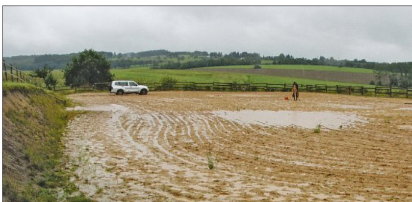
Wenn die Entwässerung nicht stimmt, kann es schnell so aussehen. Foto: Marko Münster
