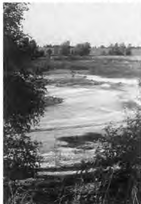
Stillgelegtes Schlammabsetzbecken, Foto: B. Morell
