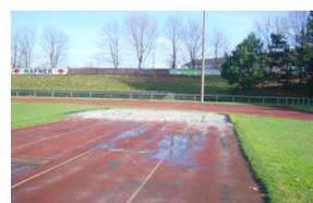
Diese Bilder zeigen deutlich, dass hier Handlungsbedarf besteht. Die Stolperkanten, Löcher und sonstigen Beschädigungen sind für die Wettkämpfer und auch für die trainierenden Leichtathleten eine große Gefahr. Darüber hinaus ist das Aufschieben der nötigen Reparaturen später oft mit einem kostspieligeren Aufwand verbunden.
