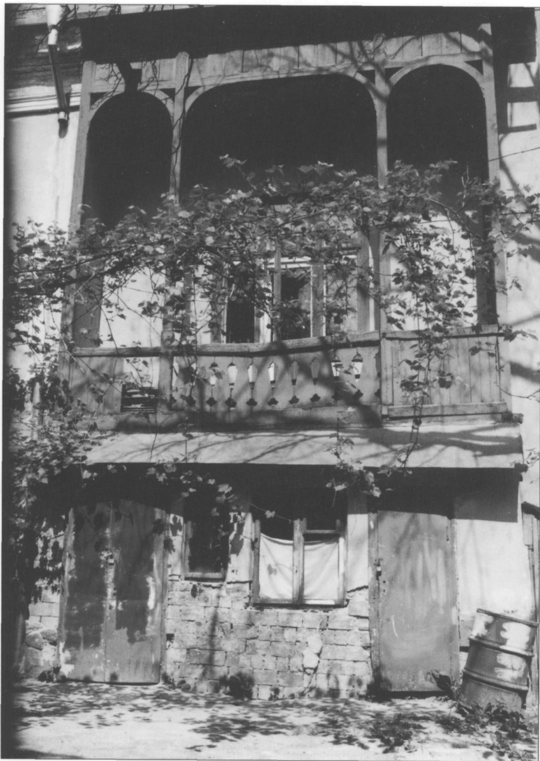
WEINBEWACHSE- NER HOLZERKER in einem Innenhof der Altstadt.
