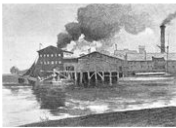
Die Portland-Zementfabrik-Itzehoe um 1895
