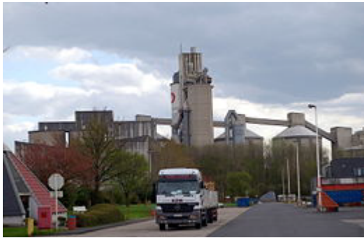
Silhouette des Zementwerks Dyckerhoff in Neubeckum/Westf. mit Vorwärmerturm (Mitte), Silos und Förderbandbrücken.
