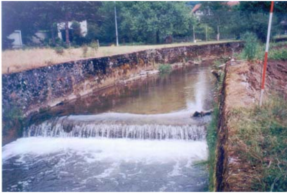
Abb. 5-24 Alter Bachlauf mit Querschwelle im Bereich Schatthole [Foto: URBANUM 2001]
