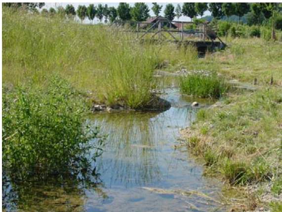
Abb. 5-22 Der Lötchenbach, ein Jahr nach der Revitalisierung, Juni 2002. Parallel dazu liegt der weiterhin bestehende Entlastungskanal.
