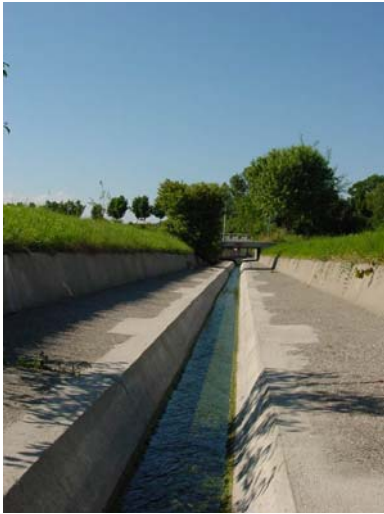
Abb. 5-21 Der weiterhin bestehende Entlastungskanal, Juni 2002
