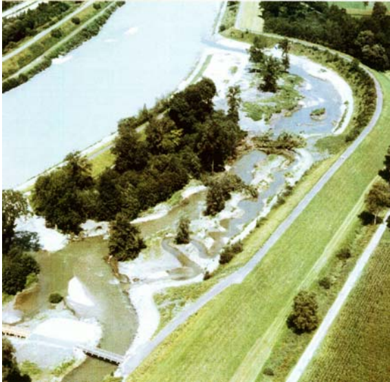
Abb. 5-15 Neugestaltung Binnenkanalmündung August 2000 [Foto: E. Ritter Tiefbauamt Vaduz]
