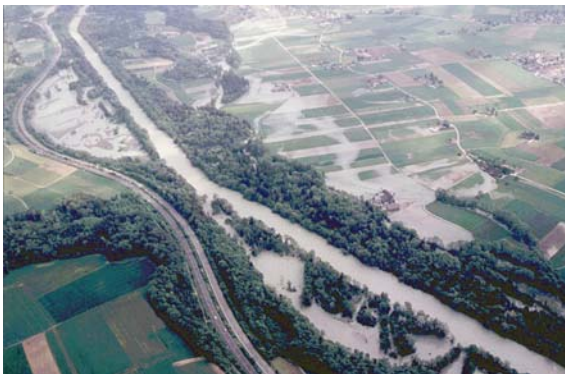
Abb. 5-19 Im Vordergrund ein Hochwasserereignis im Bereich des neuen Seitenarmes [Foto: Tiefbauamt Bern]
