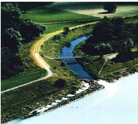
Abb. 5-14 Alter Zustand der Binnenkanalmündung mit der Fischtreppe und dem vier Meter hohen Absturz, 1985 [Foto: E.Ritter Tiefbauamt Vaduz]
