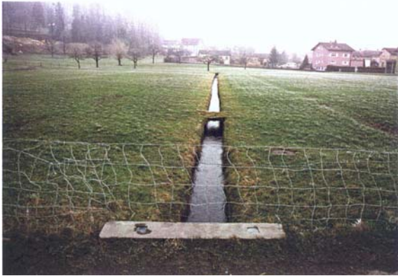
Abb. 5-30 Dorfbach Altdorf 1997 vor der Revitalisierung [Foto: AMT FÜR TIEFBAU/WASSERBAU Kanton Uri, 1998]
