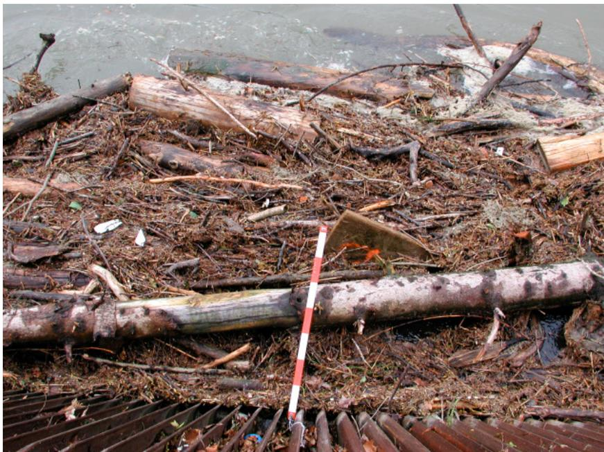
**Abb. II-3.** Schwemmgutteppich am Rechen des Wasserkraftwerks Beznau (Messlatte: 0.7 m); Foto: N.Trottmann.
