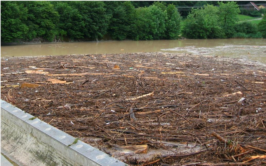
**Abb. I-1.** Schwemmgutteppich am Rechen des Wasserkraftwerks Bannwil an der Aare (CH) während eines Hochwassers 2002; Foto: Urs Hofstetter, Atel.
