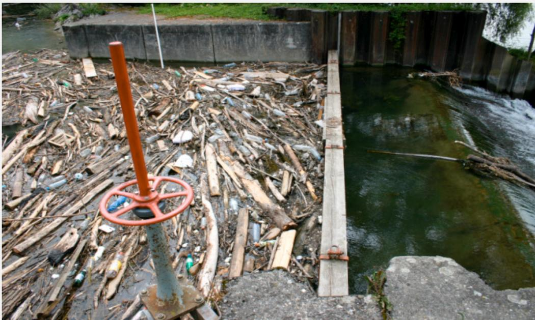
**Abb. I-5.** Senkbalken beim Ausfluss eines Geschwemmselbeckens.
