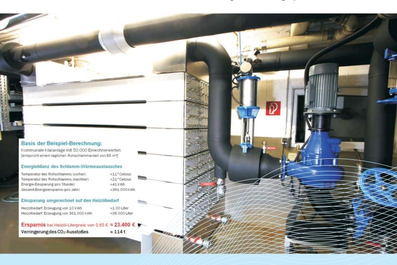
In dieser Tatsache begründet liegt die Entwicklung unseres Rekuperators. Die im ausgefaulten Schlamm enthaltene Wärme kann durch den Rekuperator in erheblichem Umfang wieder zurückgewonnen werden. Der Schlamm-Rekuperator in Modulbauweise (Deutsches Patent- und Markenamt DE 20 2010 003 704.2) arbeitet dabei nach dem Prinzip eines Wärmetauschers, bietet jedoch deutliche Verbesserungen.
