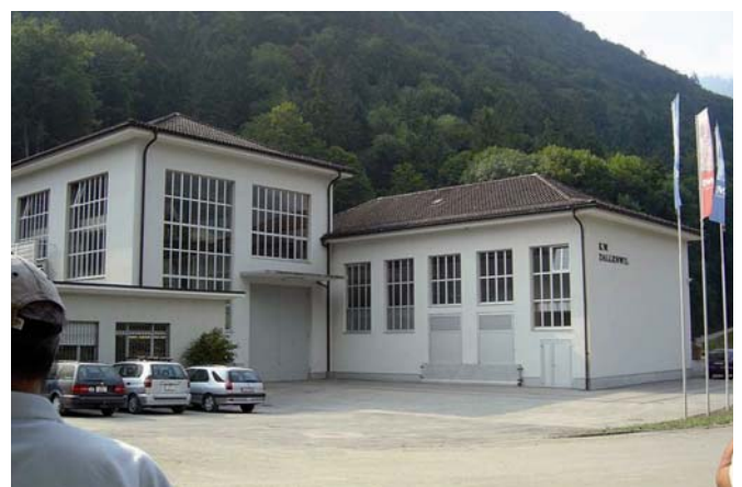
Abb. 8.9 > Kraftwerk Dallenwil mit Objektschutzmassnahme.
