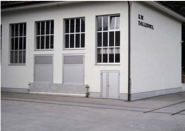
Abb. 8.13 > Objektschutzmassnahmen am Wasserkraftwerk Dallenwil.
