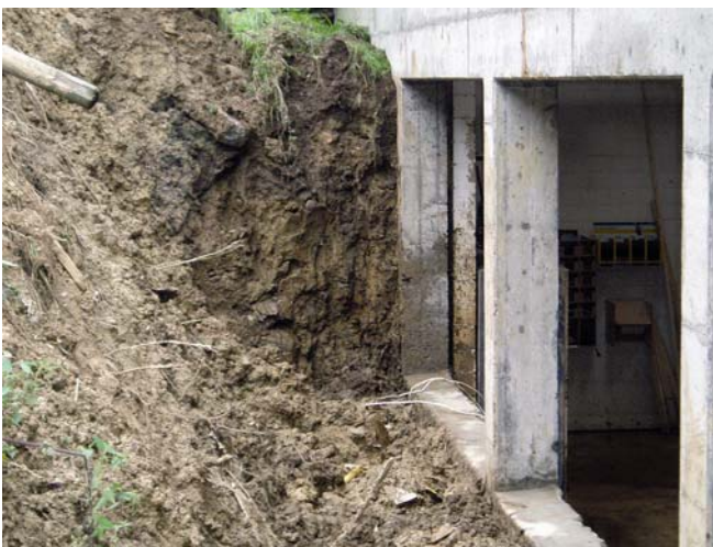
Abb. 8.11 > Aufstau der Erdmassen an der bergseitigen Wand.
