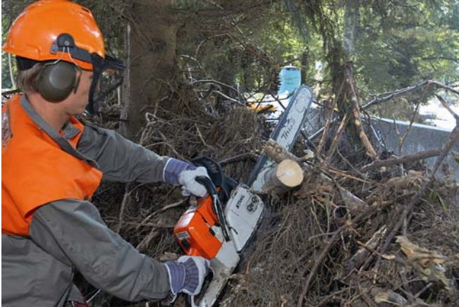
Abb. 9.6 > Zivilschutz im Einsatz in der Instandstellung.
