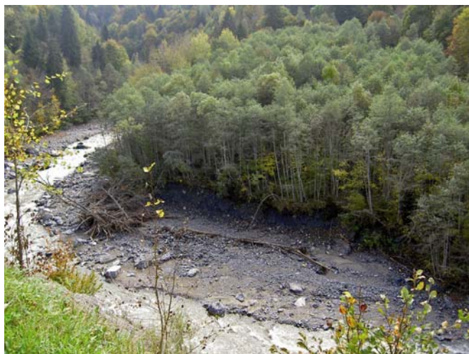
Fig. 4.22 > Erosion de forêt d'aulnes blancs et dépôts de bois flottant à Saas/Conters GR – Landquart.
