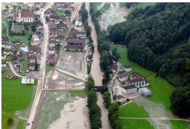
Abb. 8.8 > Kraftwerk Dallenwil während des Unwetters 2005.
