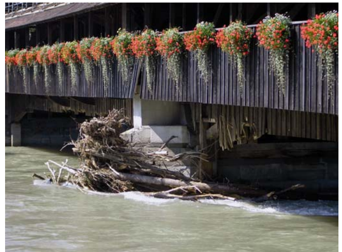
Foto: Amt für Tiefbau Kt. ZG
