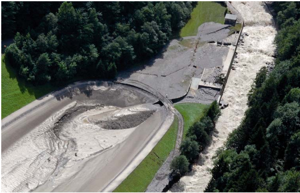
Abb. 5.24 > Austrittsstelle im Bereich der Entsanderanlage zwischen dem Tirolerwehr der Fassungsanlage (am rechten oberen Bildrand) und dem oberen Ende des Ausgleichsbeckens.
