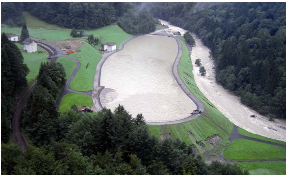
Abb. 5.27 > Ausuferung der entlang des Ausgleichsbeckens verlaufenden Engelberger Aa und Erosion des luftseitigen Fusses des Umfassungsdammes.
