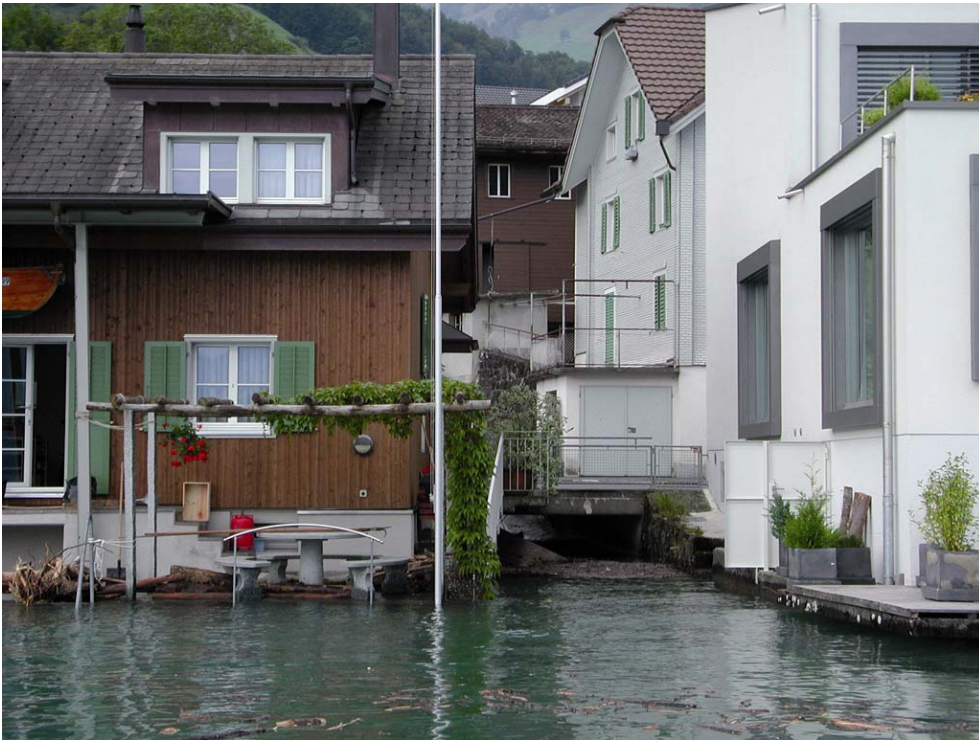
Abb. 8.7 > Gebäude am Vierwaldstättersee in Beckenried während des Hochwassers.
