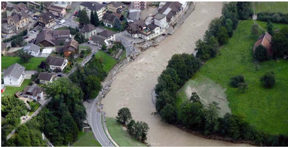
Abb. 4.7 > Seitenerosion an der Kleinen Emme: Strömung an einem Prallhang ohne Ausuferung, Ufer mit Ufermauer verbaut.
