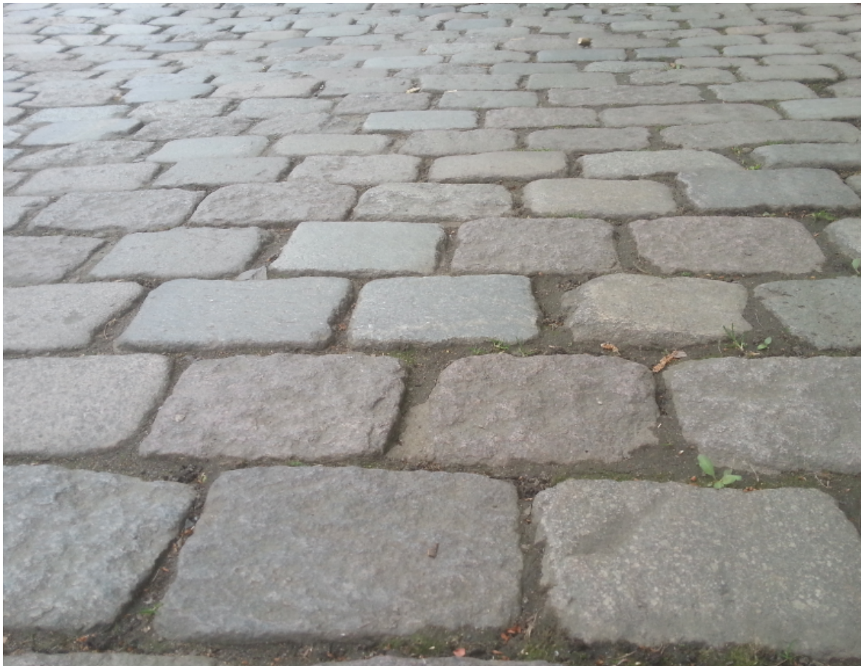
Abbildung 2.4: Pflasterdecken, abfotografiert auf der Lindenerstraße am 18.03.2014 um 14:00 Uhr
