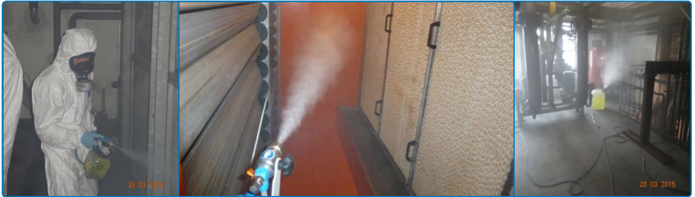
Vernebelung von Raumluftechnik Anlagen (RLT)
