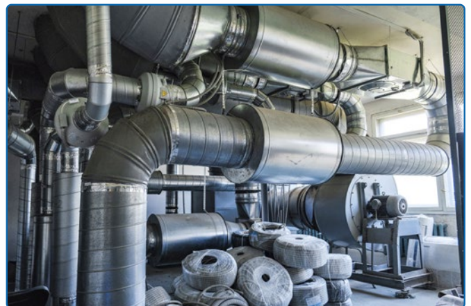
Vernebelung von Klima- und Lüftungstechniken
