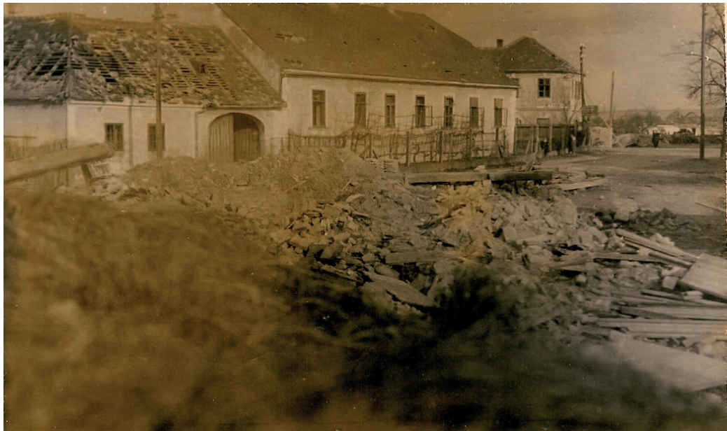
Das durch drei Bombenvolltreffer am 7. Februar 1945 total zerstörte Bauernhaus der Familie Reither in Moosbierbaum 24, rechts im Hintergrund sieht man das ebenfalls zerstörte Haus des Schmiedemeisters Pichler in der Sackgasse.
