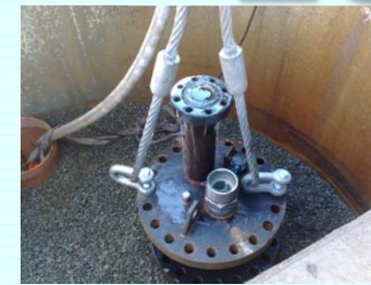
Fertiger Einbau der Rohre
