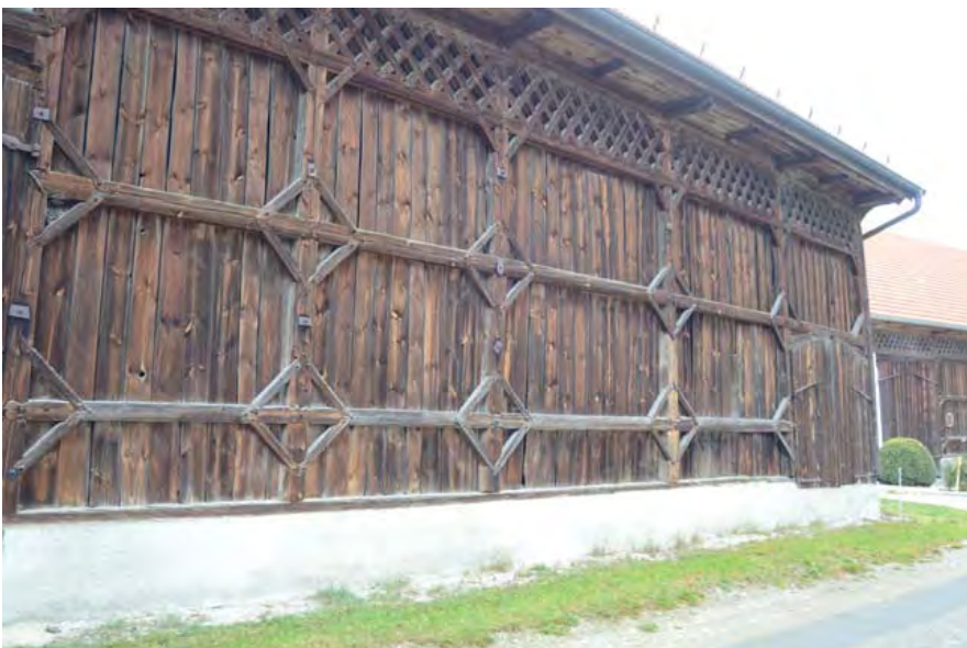
Abb. 8. Die Bundwerkfassade ist zum Ortszentrum hin orientiert (o.), der benachbarte Stadel im Bildhintergrund wurde in gleicher Bauweise errichtet (u.).
