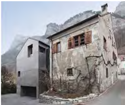
Abb. 15, Casascura in Fläsch. Ein neuer Wohnteil wurde an Stelle des Stadels errichtet.
