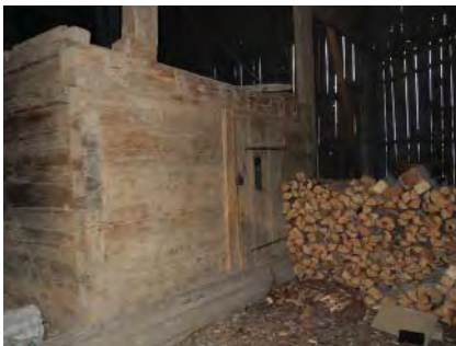
Abb. 51, Der nachträglich eingebaute Blockbau wird entfernt.
