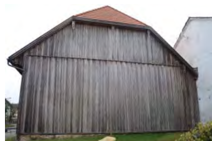
Abb. 28, Die vertikal verschaltete Fassade Richtung Nordosten mit dem angrenzenden Stallgebäude.
