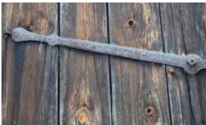
Abb. 24, Geschmiedete Beschläge an den einfach verschalteten Toren.
