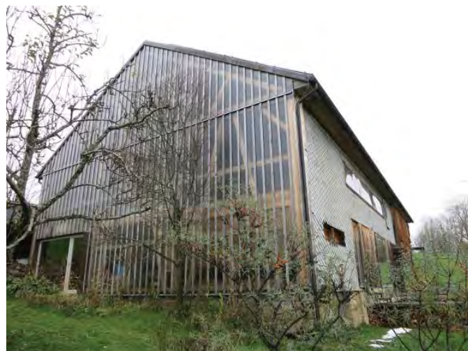
Abb. 105, Die westseitige Giebelwand
