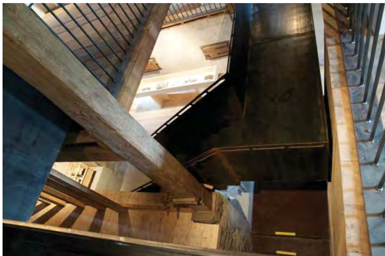
Abb. 100, Die Ebenen und Stiegen lassen Durchblicke über die gesamte Gebäudehöhe frei
