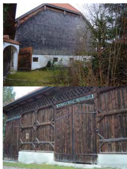
Abb. 7, Stadel in Hochburg-Ach: Südwest- (o.) und südostseitige Ansicht (u.)
