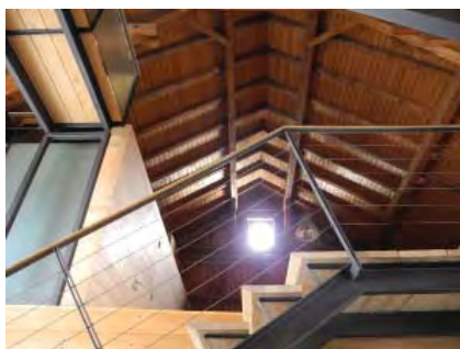
Abb. 9, Der Einfall des Tageslichts bei einfacher Holzverschalung der Außenwände im Stadel von Hochburg-Ach (o.) und durch eine gitterförmige Holzstruktur bei der Artenne in Nenzing (u.).
