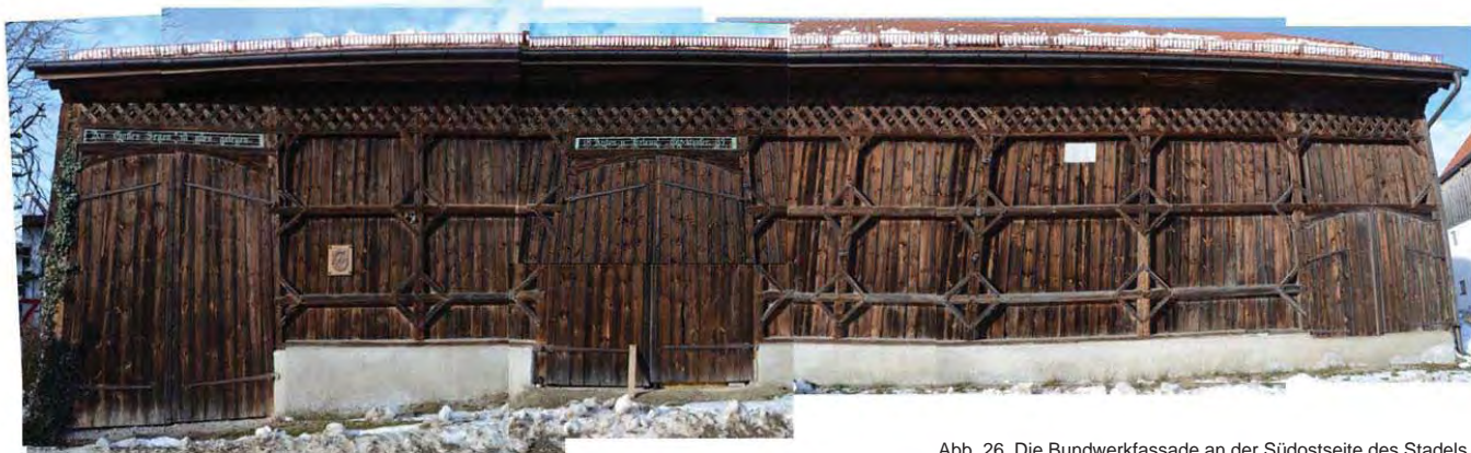
Abb. 26, Die Bundwerkfassade an der Südostseite des Stadels.
