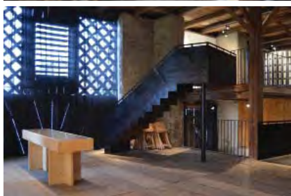
Abb. 9, Der Einfall des Tageslichts bei einfacher Holzverschalung der Außenwände im Stadel von Hochburg-Ach (o.) und durch eine gitterförmige Holzstruktur bei der Artenne in Nenzing (u.).
