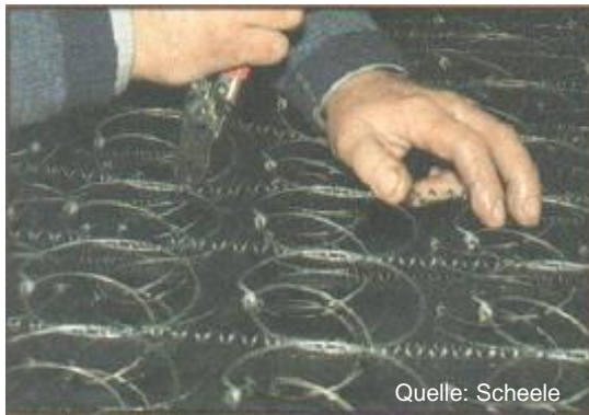
Montage der Spiralfedern
