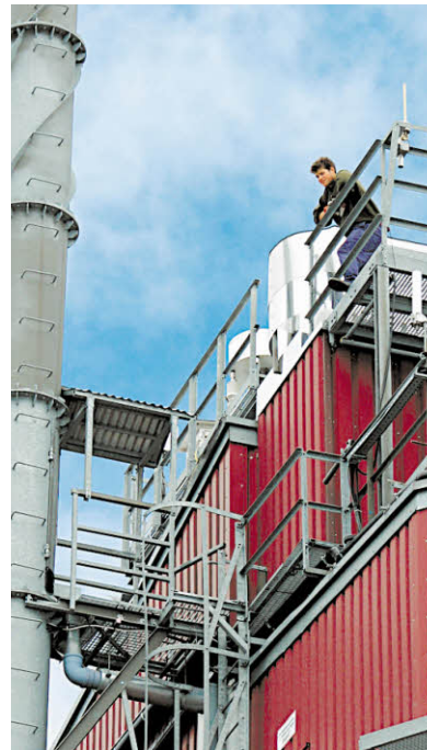
Auf dem Dach des Observatoriums wird Luft für Schadstoffanalysen angesaugt.
