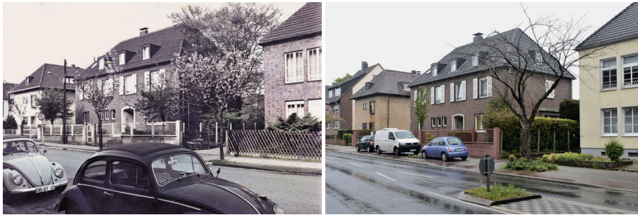
Abbildung 3.22: OB · ALO · 10 Hochwertige Mehrfamilienhäuser. Die Häuser im Stil der 20er-/30er-Jahre in der Kewerstraße wurden vermutlich für Führungskräfte der fußläufig gelegenen Zeche Alstaden gebaut. Das mittlere und das linke Haus sind äußerlich unverändert und gut instand gehalten, das Haus rechts versteckt seine Klinkerfassade hinter einem neuen Wärmedämmputz. Der Bürgersteig wurde erneuert und erhielt einen Radstreifen, ältere Straßenbäume wurden durch neue ersetzt. (Quelle: Scharioth und Schräpler 2017)
