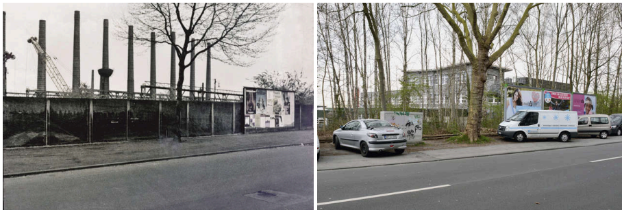
Abbildung 3.5: BO · WE · 10 Schornstein-Batterie der ehemaligen »Rombacher Hütte« an der Schützenstraße. Derselbe Blick trifft heute im Sommer auf eine blickdichte Baumreihe, im Winter ist die »Werkstatt Constantin-Bewatt« für Menschen mit Behinderungen der Diakonie Ruhr zu sehen, die sich im nach 1980 entstandenen Gewerbepark »Rombacher Hütte« befindet. Die früher stadtbildprägende Wirkung des Areals ist verschwunden. (Quelle: Scharioth und Schräpler 2017)
