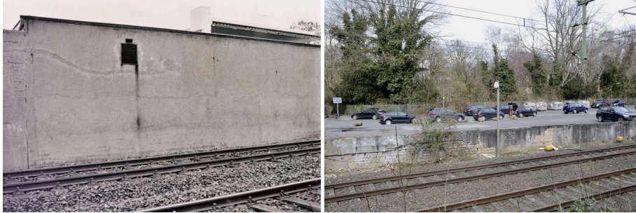
Abbildung 3.25: DO · DB · 06 An der Regionalbahn. Der Schuppen an der Rittershausstraße an der Nordseite der Regionalbahnstrecke durch die südliche Innenstadt wurde abgerissen, dort befindet sich seit den 70er- oder 80er-Jahren ein öffentlicher Parkplatz. Die danebengelegene Fußgängerbrücke aus den 50er-Jahren wurde durch eine neue ersetzt. Die Bahnstrecke wurde elektrifiziert. (Quelle: Scharioth und Schröppler 2017)
