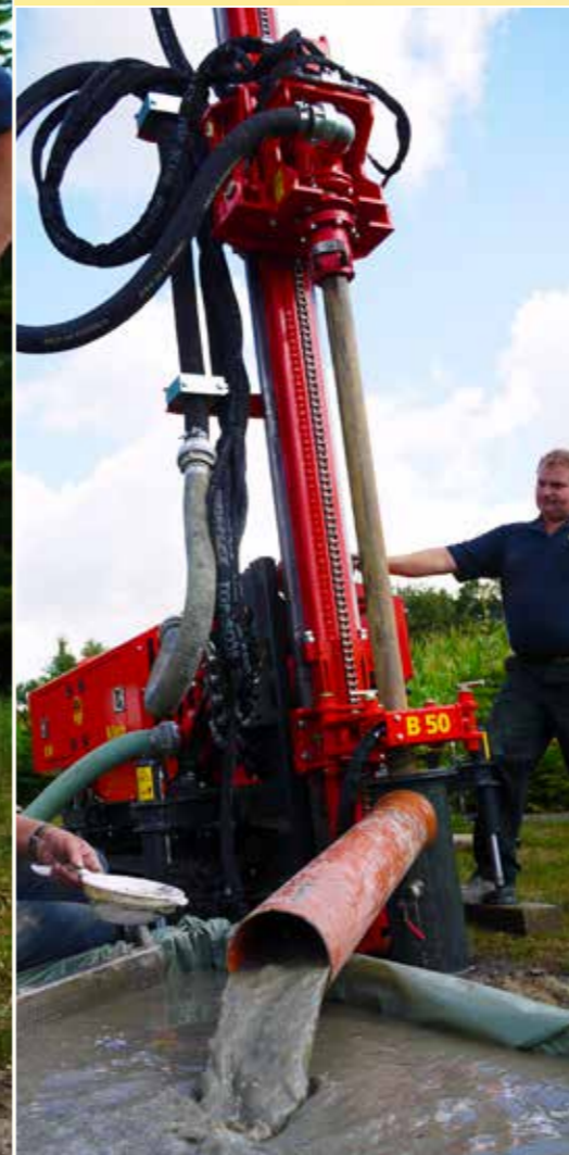
Entnahme von Materialproben aus dem Spülbohrwasser
