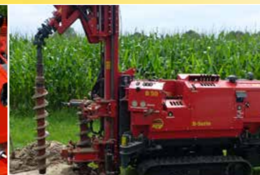
Bohren mit Hohlbohrschnecke und Kreuzgelenk
