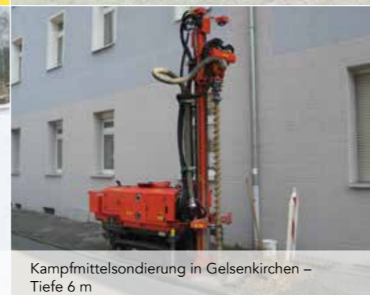
B 25 mit Ablagemagazin für Bohrschnecken
