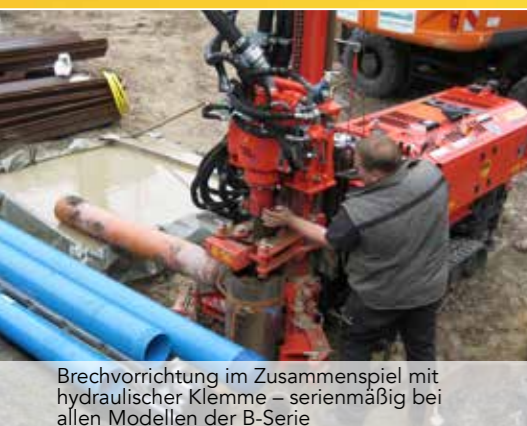
Ausbau des Bohrgestänges mittels Brechgabel
