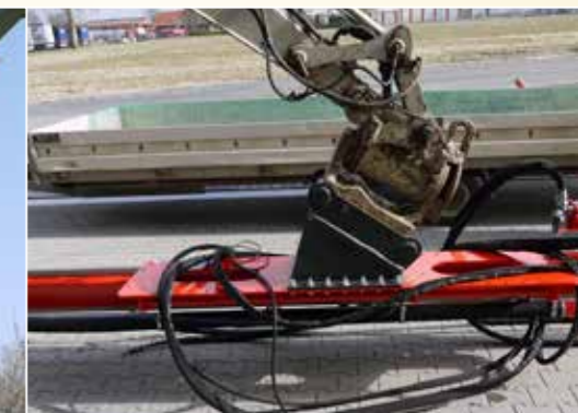
Aufnahme der Bohrlafette über den Schnellwechsler des Baggers
