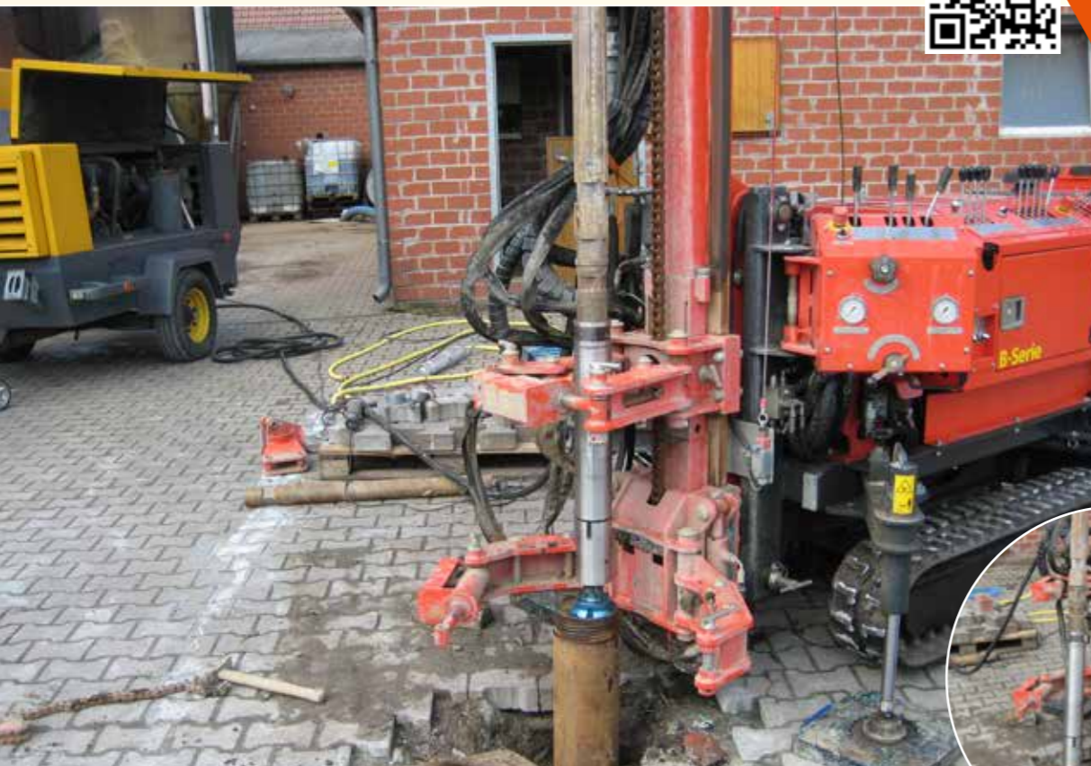
B 50 mit Imlochhammerausrüstung
