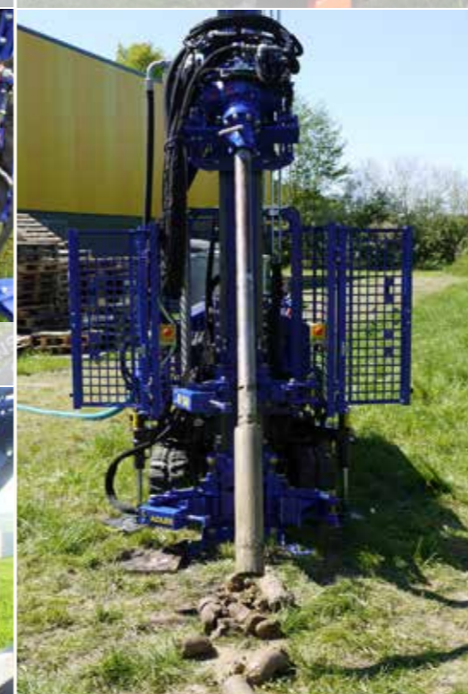
Kernbohrungen mit einem Einfachkernrohr oder mit Doppelkernrohr
