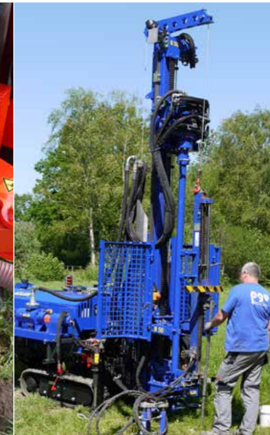
Rammsondieren mit dem ADLER-Bohrgerät B 50
