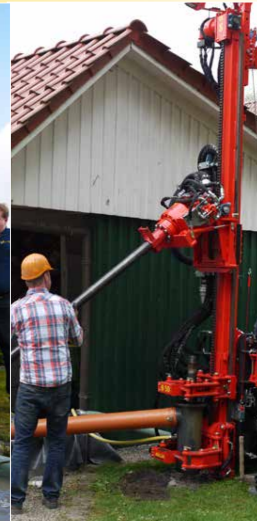
Gestängewechseln beim Spülbohrverfahren
