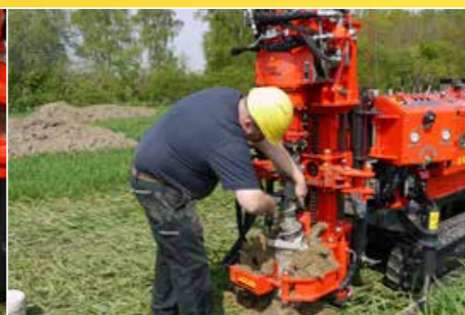
Trockenbohrung mit Außenverrohrung
