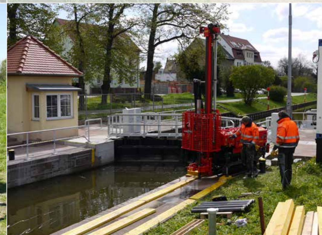
Kernbohrung an einer Kanalschleuse
