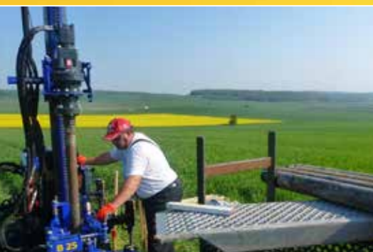
Bohrgerät B 25 im Einsatz beim Kerne ziehen
