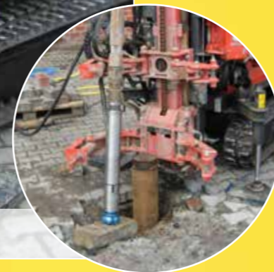
3" Imlochhammer mit Bohrkone
