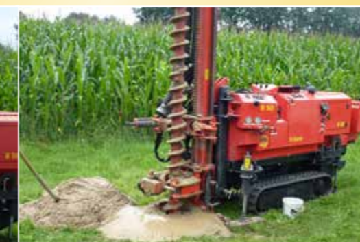
Arbeiten mit der Hohlbohrschnecke
