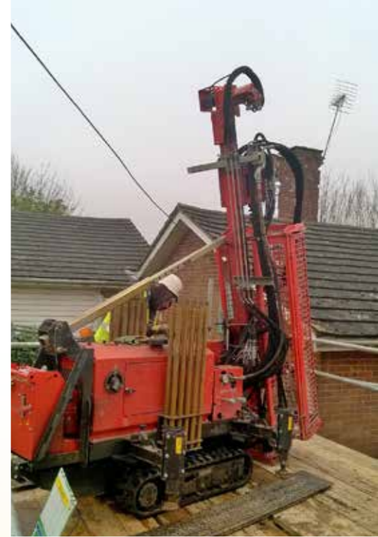
Sondierbohrung zum Orten von Hohlräumen.
