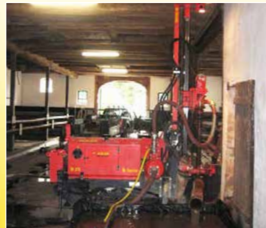
Bohren im Stall
