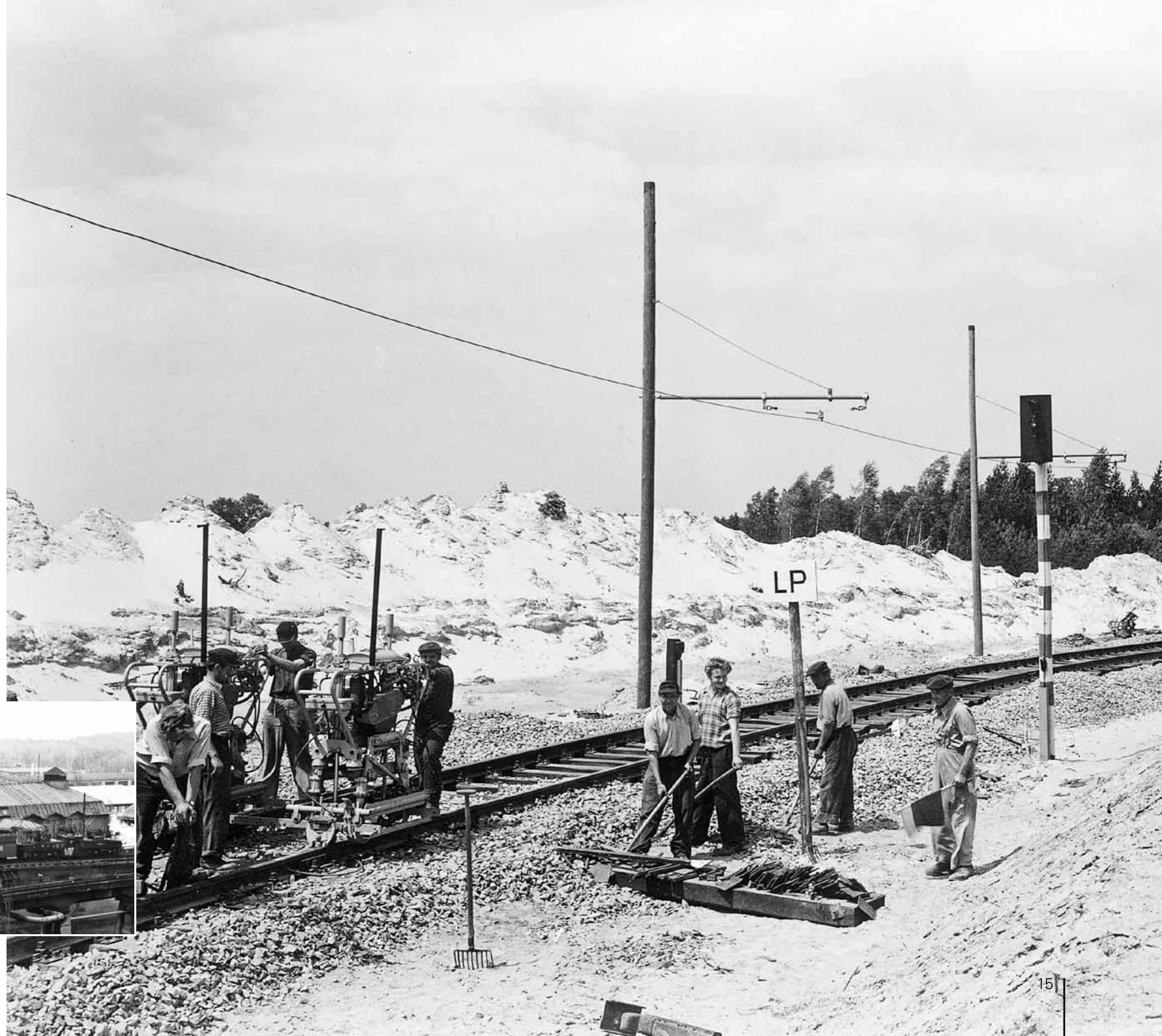
Errichtung der Zufahrt zur Außenkippe des Tagebaus Seese-West, 1962
