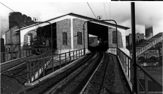
Kohlenbunker der Brikettfabriken Renate/Eva, 1924
