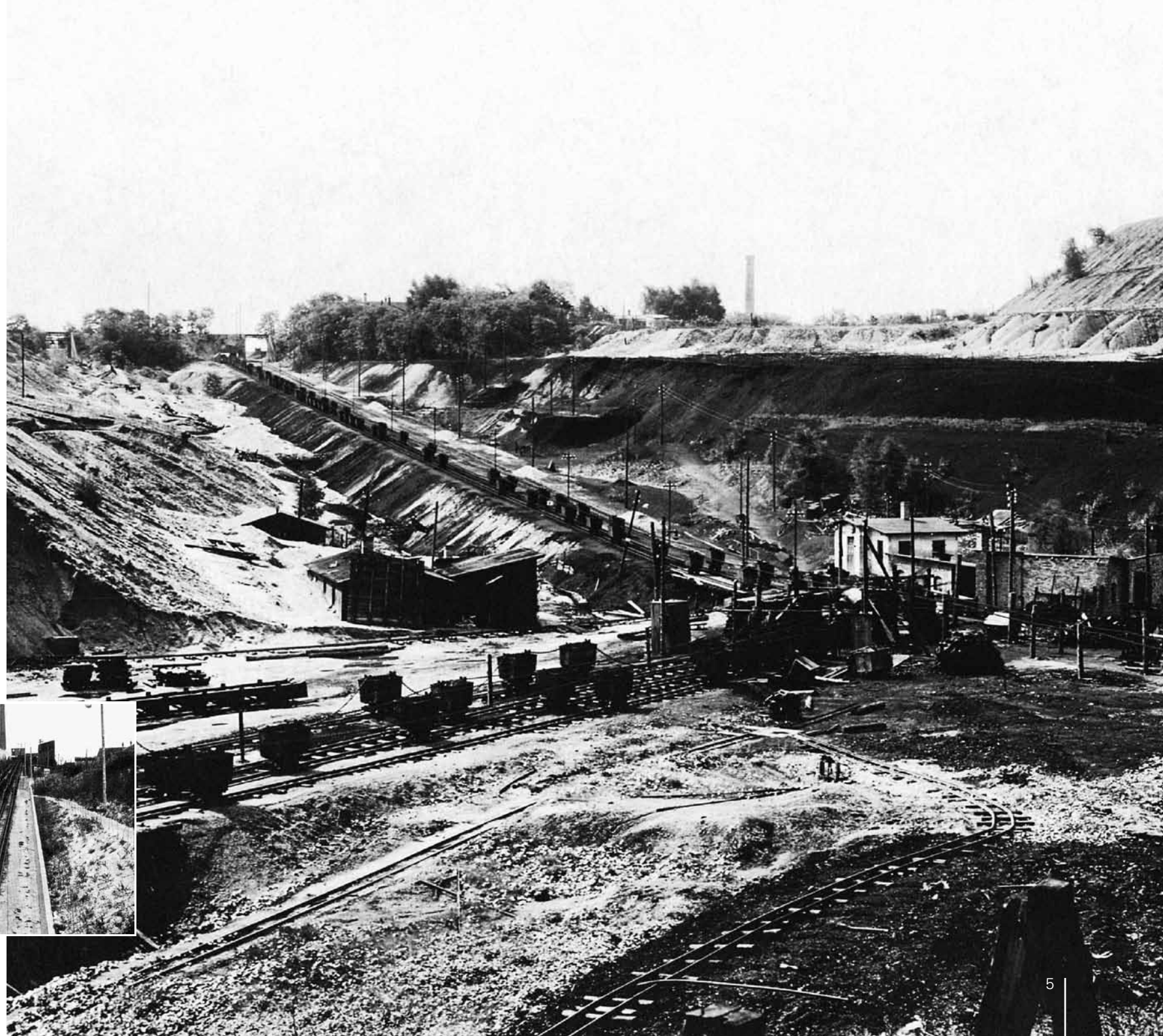
Kettenbahn vom Tagebau Friedrich-Ernst bei Senftenberg zur Brikettfabrik, 1910
