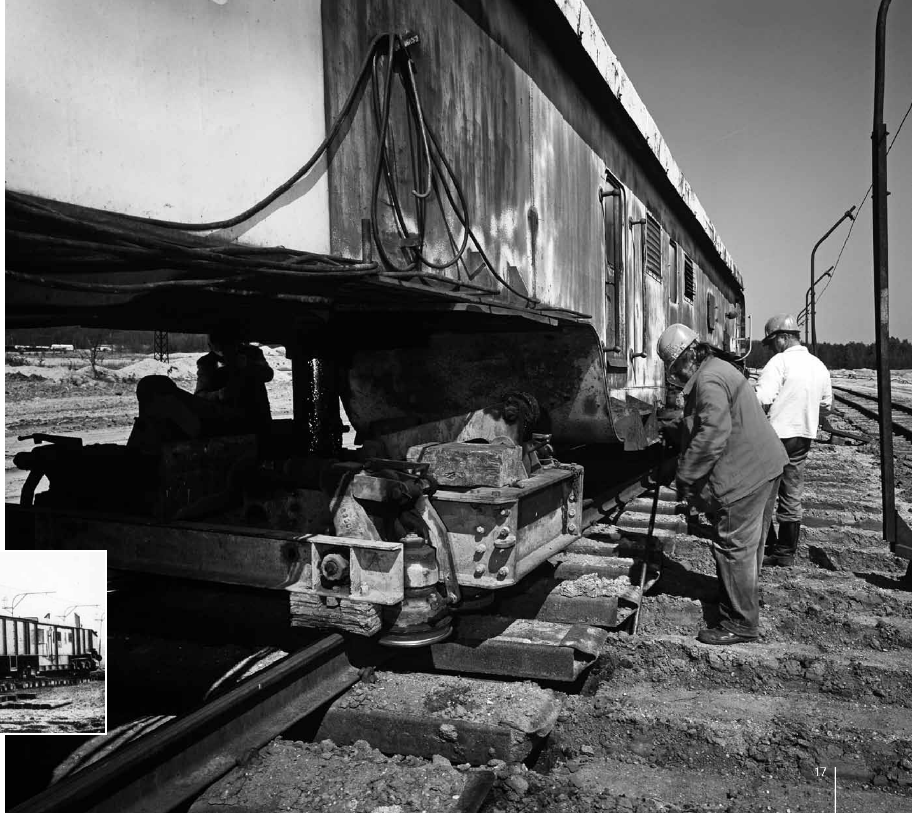
Diesel-Gleisrückmaschine 396 beim Anheben der Strossengleise im Sanierungstagebau Klettwitz, 2004
