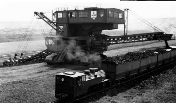
Dampfbespannter Kohlenzug bei der Beladung durch einen Eimerkettenbagger, um 1930
