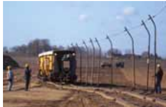
Gleisrückmaschine im Sanierungstagebau Schlabendorf-Süd, 1997
