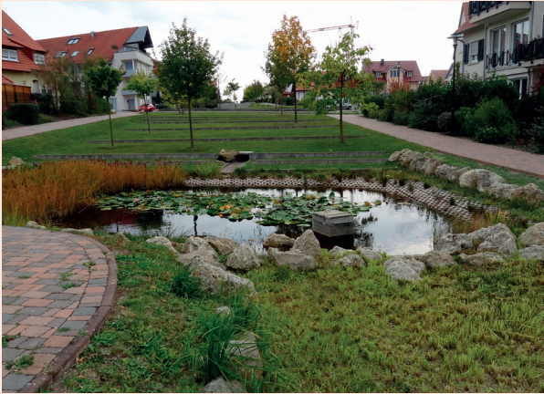
Abb. 6.16 Regenrückhaltung im Quartier Versickerungsanlage Beispiel Bad Dürkheim 34 rechts: Versickerungsmulde in einem Spielplatz 35
