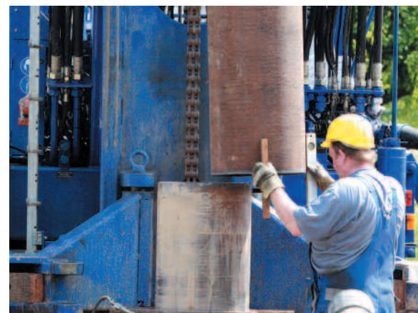
Mitarbeiter beim Einbau einer Rohrtour
