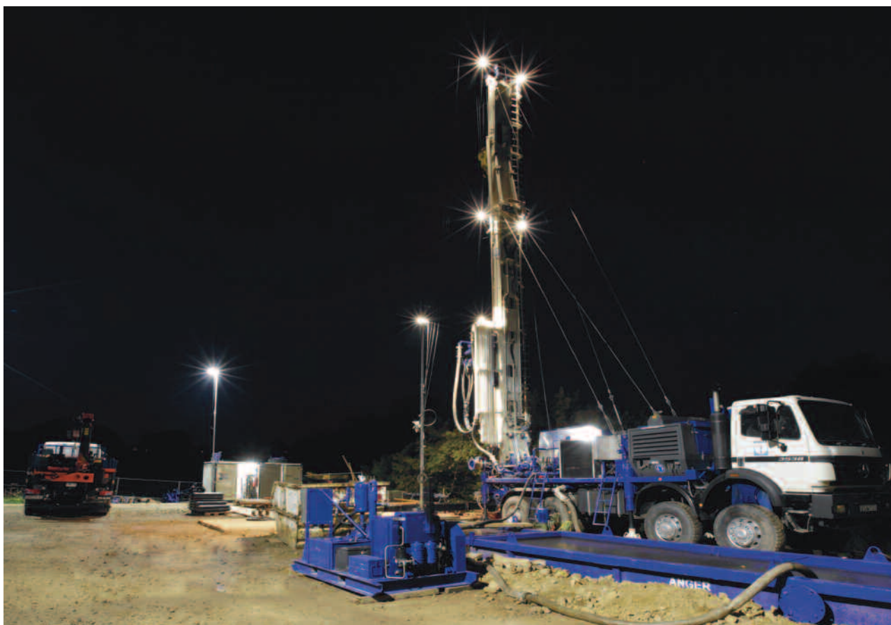
Bohrarbeiten im Zweischichtbetrieb
