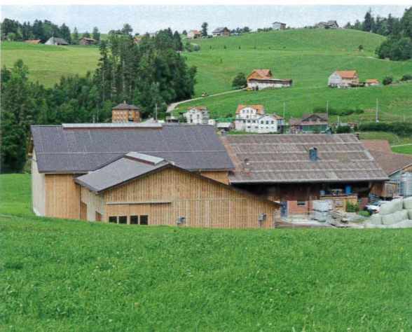
Der bisherige Stall wurde mit Liegeboxen und einem Futter-Tenn erweitert.
