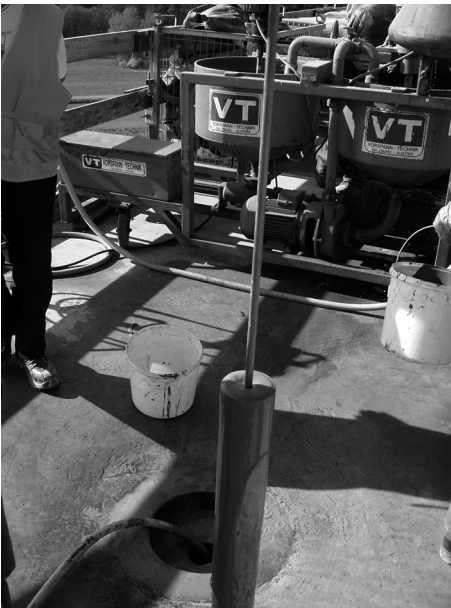
Bild 21. Verpressen von Spanngliedern: Einpressgerät (im Hintergrund), Eintauchversuch im Vordergrund
