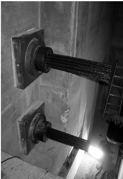
Bild 79. a) Nachträgliche Verankerung an Querträgern, mit Lastverteilungsplatte aus Stahl, b) Vorspannen mit kompakten Pressen, c) Hybridankerplatten (Foto: Autobahndirektion Südbayern)
