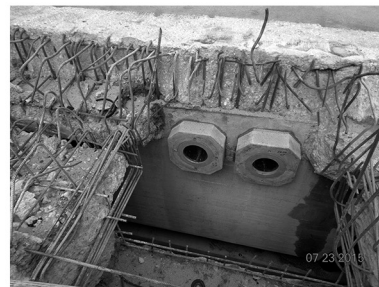
Bild 79. a) Nachträgliche Verankerung an Querträgern, mit Lastverteilungsplatte aus Stahl, b) Vorspannen mit kompakten Pressen, c) Hybridankerplatten (Foto: Autobahndirektion Südbayern)
