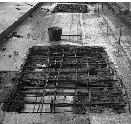
Bild 92. Schachbrettartige Öffnungen der Fahrbahnplatte mit abwechselnd mit Platten verankerten bzw. durchgehenden Querspanngliedern (Foto: Hessen Mobil)
