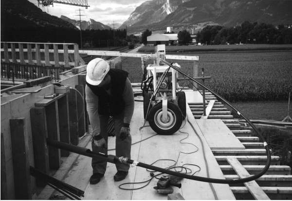
Bild 19. Einschieben von Spannstahlitzen (Foto: PAUL Maschinenfabrik GmbH & Co. KG)
