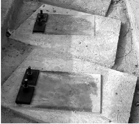
Bild 95. Geschlossene Verankerungsbereiche mit Stahlplatten und Gewindestäben der Randzugbewehrung (Foto: LSBG Hamburg)
