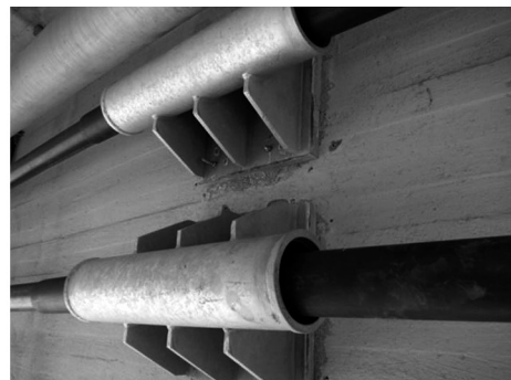
Bild 76. a) Nachträgliche Ergänzung externer Spannglieder bei Plattenbalkenbrücken, Durchdringung vorhandener Querträger (Foto: Autobahndirektion Südbayern), b) Umlenkung über Stahlbauteile (Foto: BBV Systems GmbH)
