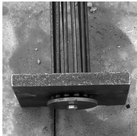
Bild 84. Temporäre Ankerplatte mit kranzförmiger Anordnung von glatten Einzelspannstäben (Foto: Hessen Mobil)
