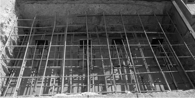
Bild 93. Gereinigter Verankerungsbereich mit Ankerplatten und Spaltzugbewehrung (Foto: Bickhardt Bau AG)
