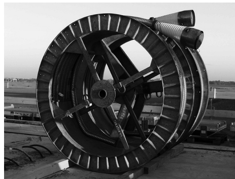
Bild 9. Werkmäßig vorgefertigte Spannglieder für nachträglichem Verbund
