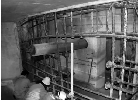
Bild 78. Querschnittsergänzung am Endquerträger eines Hohlkastenüberbaus zur nachträglichen Verankerung externer Spannglieder
