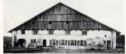
Abb. 100. «La grosse Maison» bei Les Trillères (Südschweiz).
