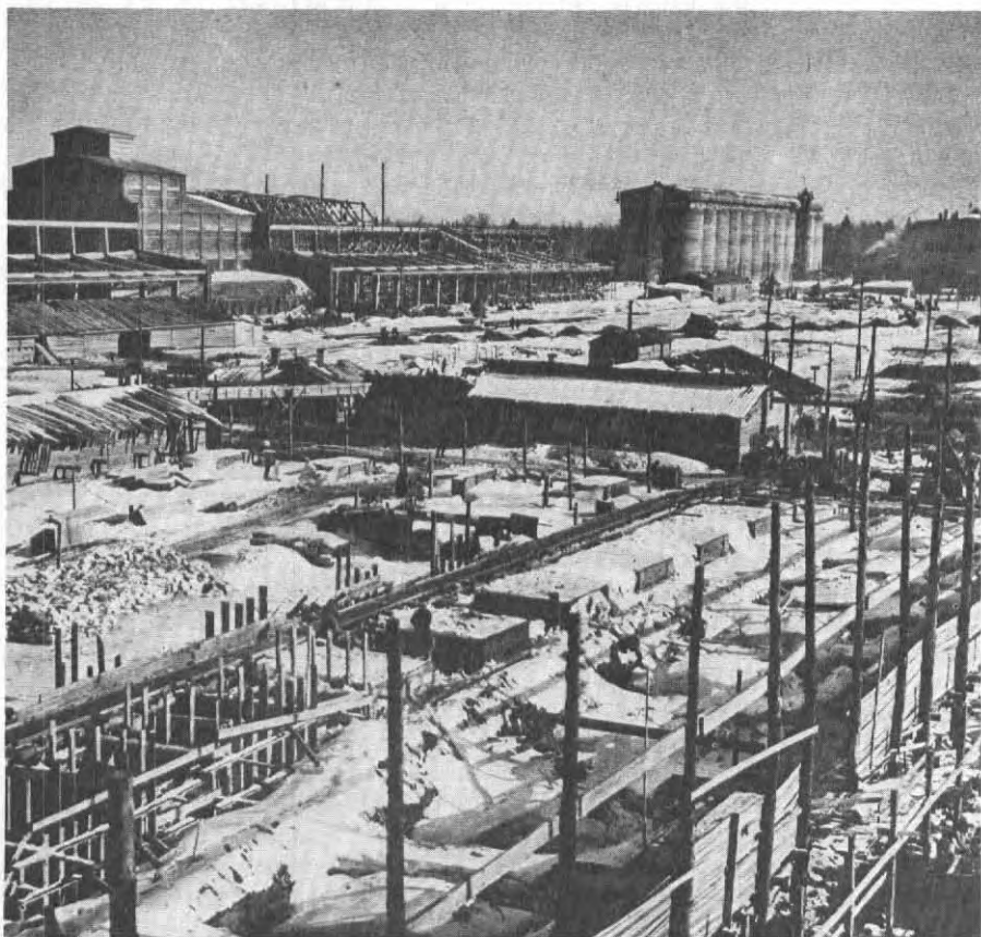
Baustelle eines Schwefelsäurewerks etwa 1930.
