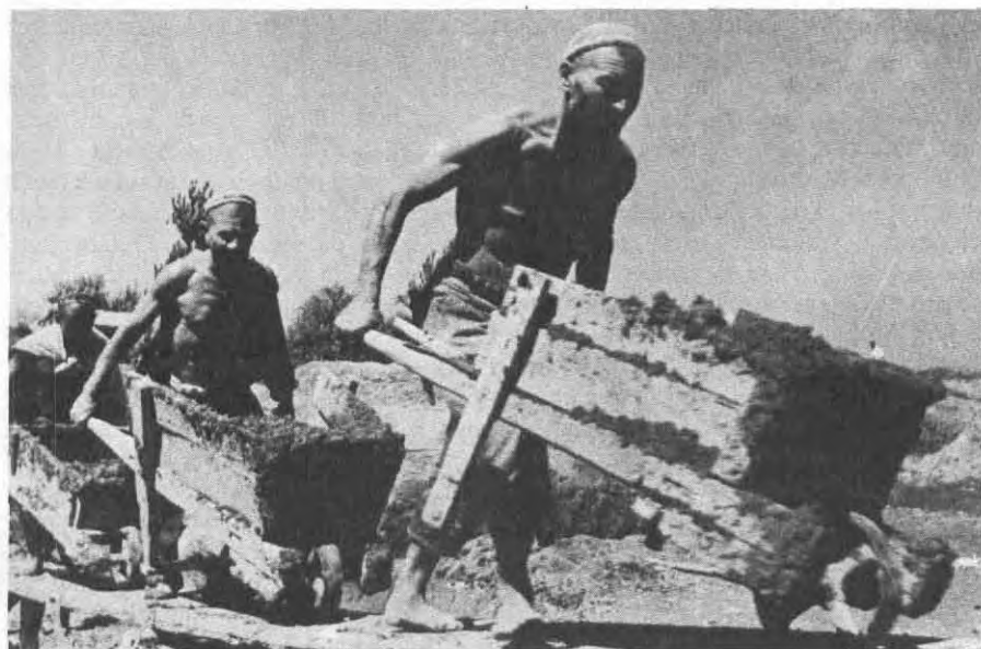
Muskelkraft verlangte der Materialtransport noch um 1930 beim Bau von Fabriken, Verkehrswegen, Kraftwerken oder dem Abbau von Bodenschätzen.
