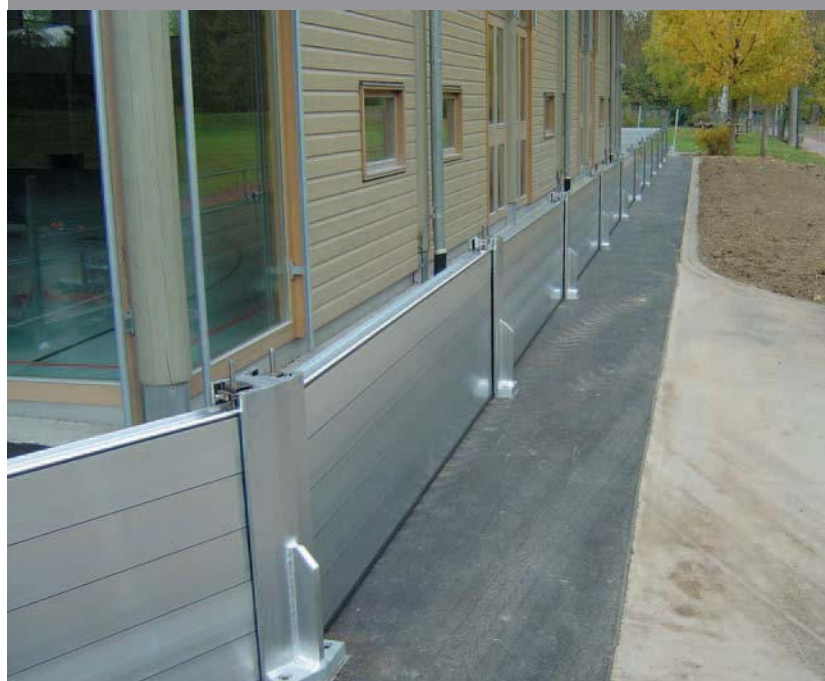
Umlaufender Hochwasserschutz mit mobilen Schutzelementen
