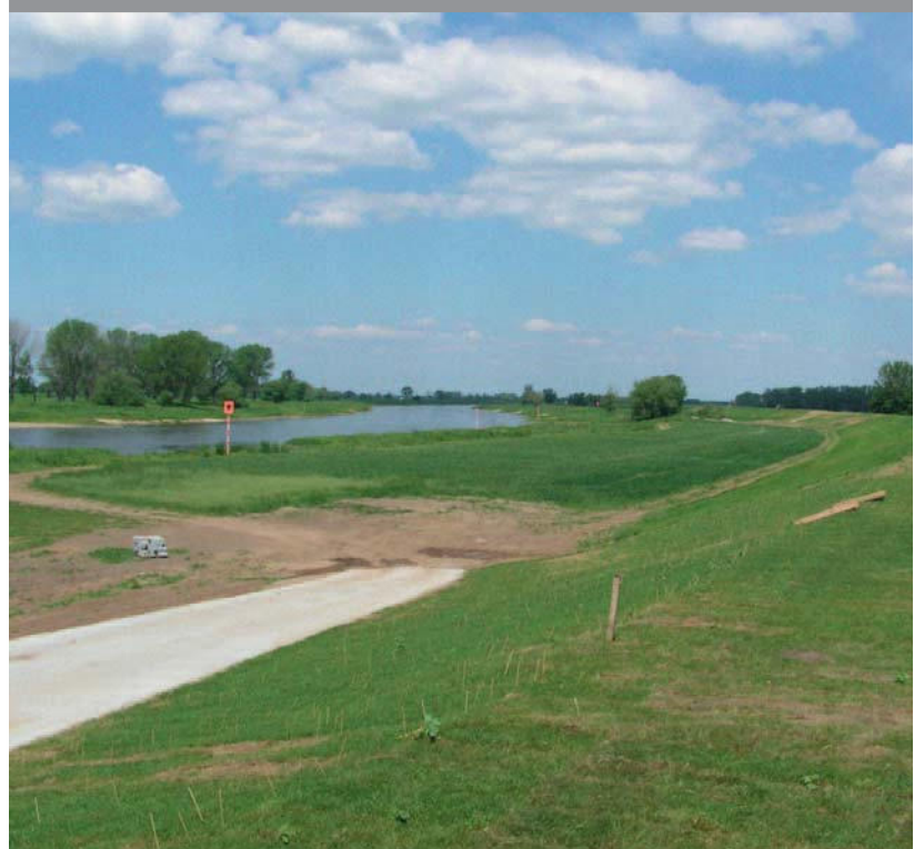
Wiederhergestellter Hochwasserschutzdeich an der Elbe
