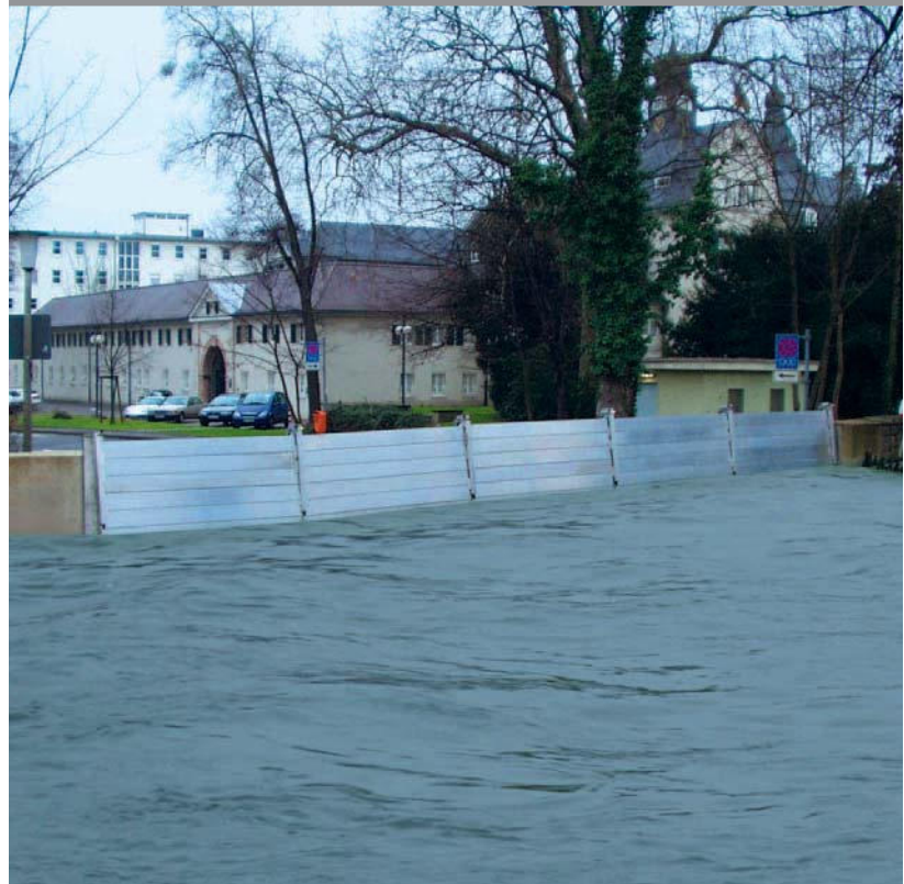
Mobiler Hochwasserschutz mit Dammbalken
