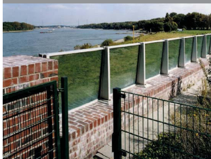
Hochwasserschutzwand mit Sicherheitsglas
