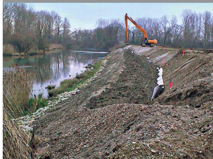
Hochwasserschutzdeich im Bau
