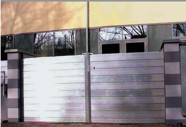
Umlaufender Hochwasserschutz mit teilmobilen Schutzelementen
