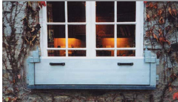
Hochwasserschutz an Fensteröffnungen
