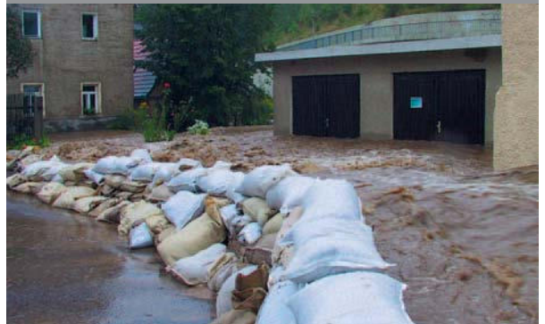
Ein Sandsackwall kann bereits sehr wirkungsvoll sein.
