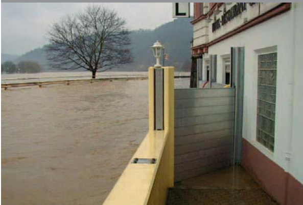
Umlaufender Hochwasserschutz mit teilmobilen Schutzelementen
