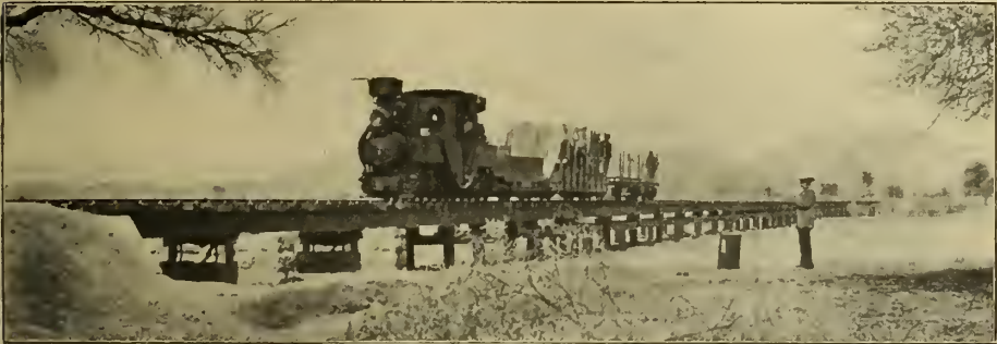
Eisenbahnbrücke bei Osona.
