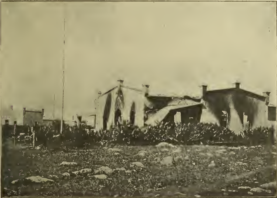
Zerförtes Haus in Okahandja.
