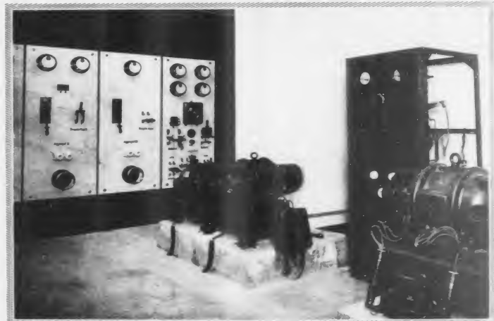
Blick in den Maschinenraum des U. T. Turmstr. B.
