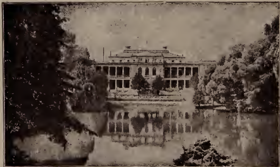
Direktionsgebäude, Blick über den Weiher auf die Terrasse
