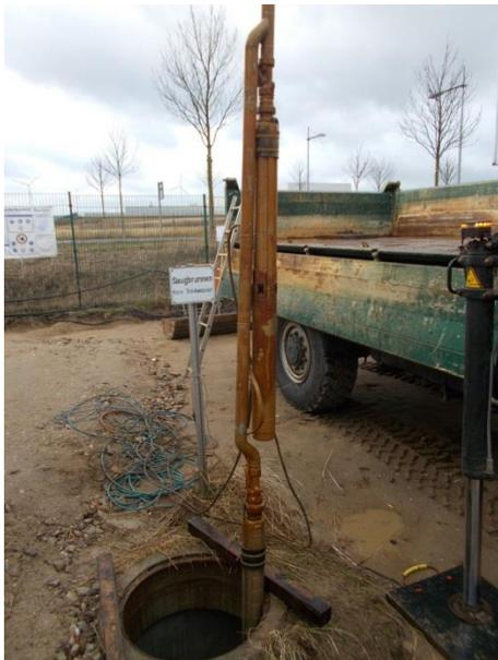
Aus- und Rückbau von 2 Pumpen mit Steigleitung und E-Kabel aus Förderbrunnen (Pumpen und Steigleitung stark verockert)
