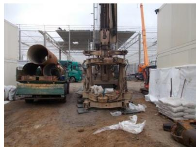
Auffüllung Filterrohr PVC DN 175 von 25–14 m unter Gelände mit Filterkies und Bereitstellung der Großlochbohranlage zum Überbohren der Brunnen
