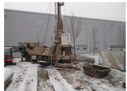
Überbohren der Brunnen mit einem Bohrdurchmesser von 1000 mm im Greiferbohrverfahren bis 14 m unter Gelände und lagenweise Verfüllung des Bohrloches mit Füllkies und Quellton, zum Abschluss 0,30 m Mutterbodenabdeckung
