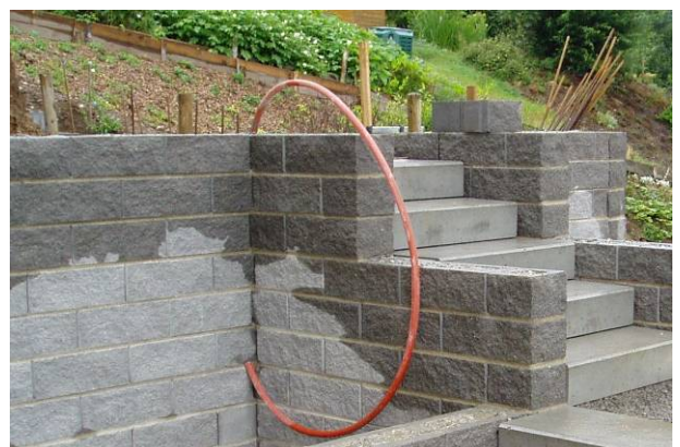
Bild 40: Einlegen der Leerrohre
