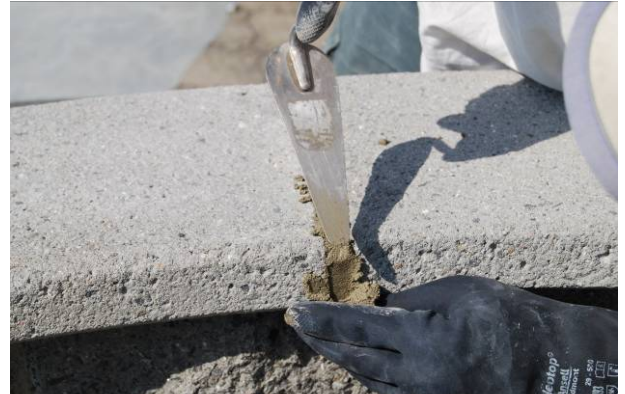
Bild 64: Verfugen der Abdeckplatten
