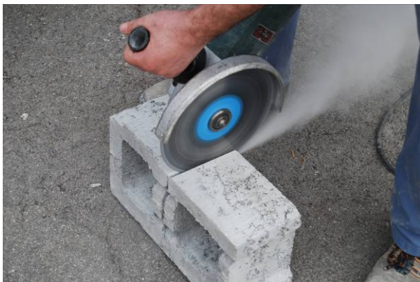
Bild 52: Trennen der Spaltsteine mit Winkelschleifer
