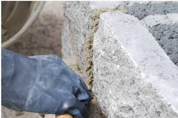
Bild 46: Modellieren der Fuge
