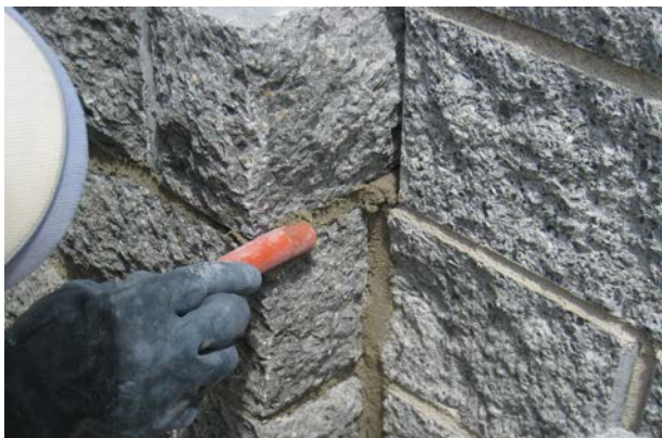
Bild 47: Modellieren der Fuge mit einem Kunststoffrohr
