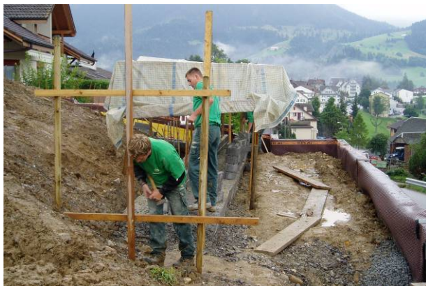
Bild 34: Setzen einer Richtschnur
