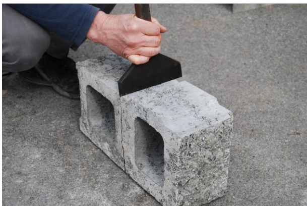
Bild 53: Trennen der Spaltsteine mit Meissel
