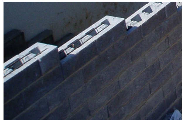
Bild 49: Bewehrungseinlagen, eingelegt in die vorgesehene Nuten
