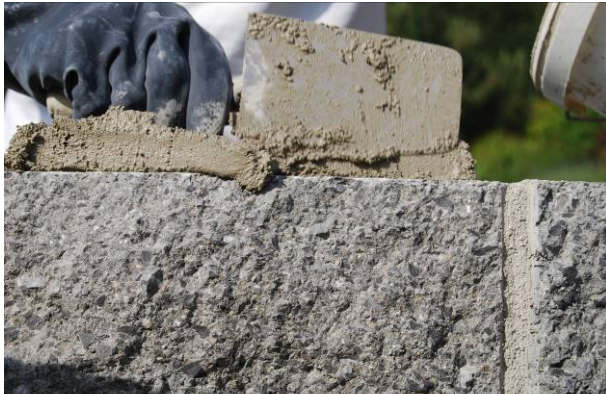
Bild 62: Erstellen der Mörtelvorlage
