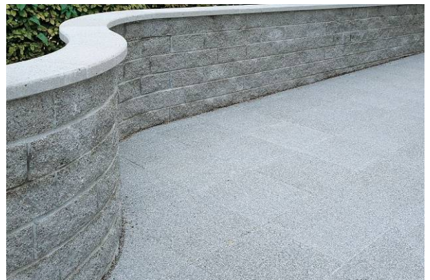
Bild 3: Mauer mit Radiusspaltsteinen
