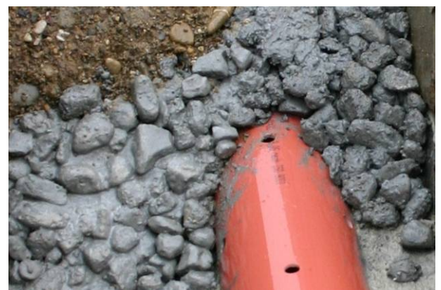
Bild 33: Eingebaute Sickerleitung
