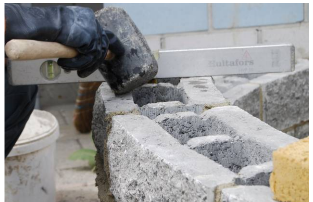
Bild 44: Richten und anklopfen des versetzten Spaltsteines
