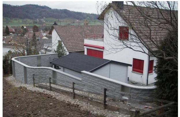
Bild 2: Doppelspaltsteine, eingesetzt als freistehende Mauer
