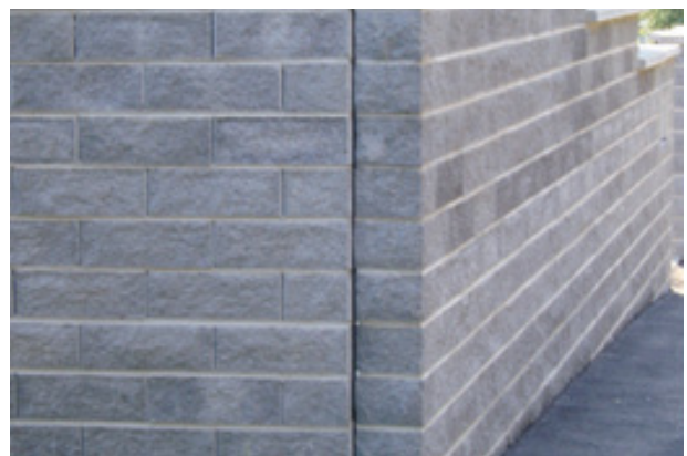
Bild 56: Vertikale Dilatationsfuge bei einer Eckausbildung
