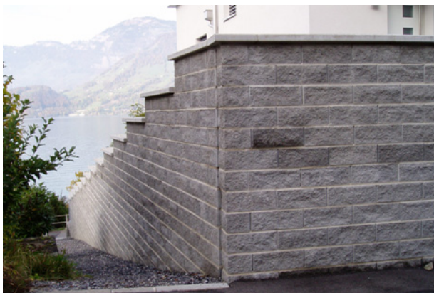
Bild 1: Spaltsteine, eingesetzt als Hangsicherung
