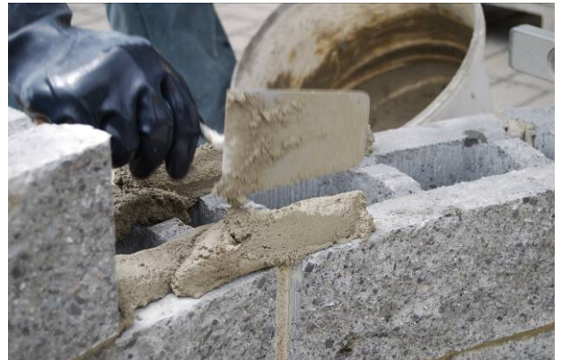
Bild 42: Aufbringen der Mörtelschicht
