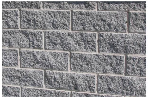
Bild 5: Oberfläche der Spaltsteine, grau mit Splittkorn
