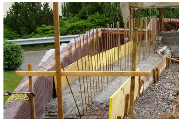
Bild 35: Fundament mit Anschlussbewehrung
