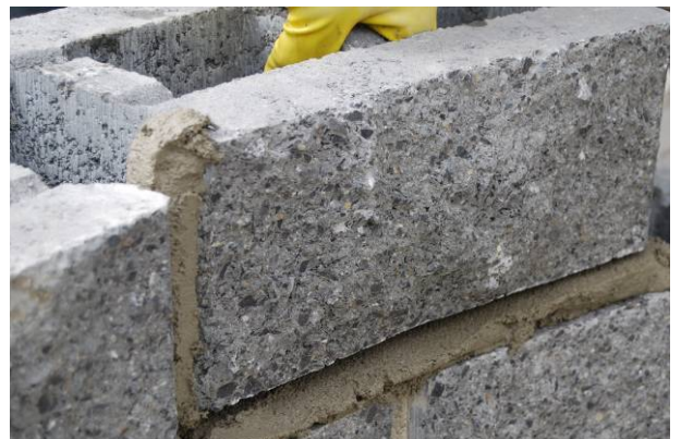
Bild 43: Versetzen des Mauersteines auf die Mörtelschicht
