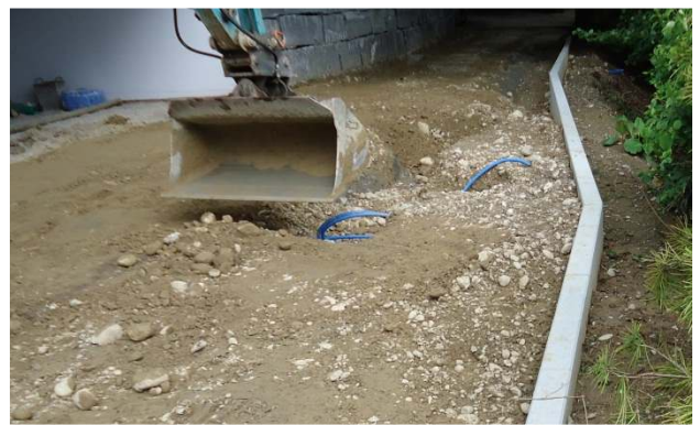
Bild 34: Lagenweises Einbringen von geeignetem Hinterfüllmaterial
