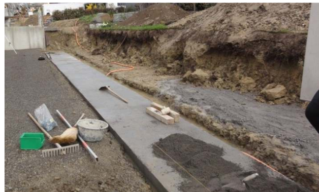
Bild 27: Erstelltes Streifenfundament
