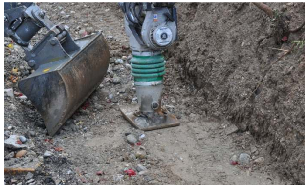
Bild 26: Erstellen der Sauberkeitsschicht
