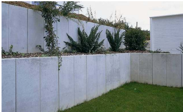
Bild 1: COMOFORTE® Winkelplatten als Böschungssicherung
