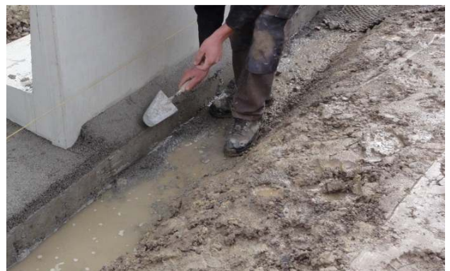
Bild 30: Erstellen der Fundamentnocken
