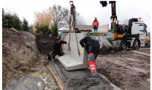
Bild 29: Versetzen der Winkelplatte auf ein Streifenfundament
