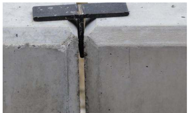
Bild 32: Optimale Fugen nach der Versetzung
