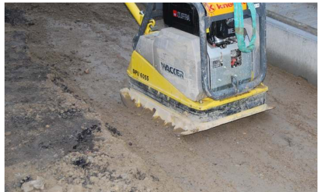
Bild 35: Verdichten nur mit leichten Verdichtungsgeräten
