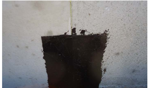
Bild 33: Abdichten der Fugen
