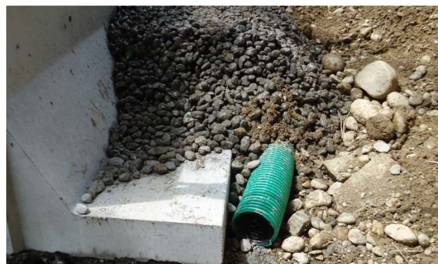
Bild 28: Einbau einer Sickerleitung mit Sickerpackung
