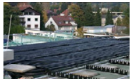
Flachdachabsorber (im Bau)
