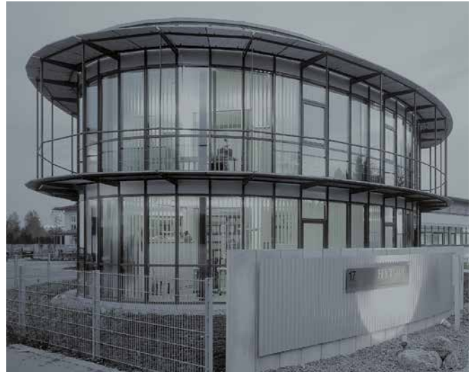
↑ HYTORC-Zentrale in Krailing bei München
