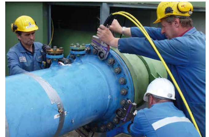
↑ SIMULTORC-Montagesystem mit der Eco2TOUCH
