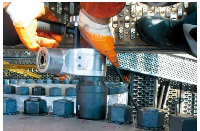
↑ Flanschmontage mit zWasher und AVANTI-3
