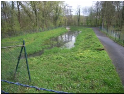
Regenrückhaltebecken mit Dauerstau und geringem Schilfbewuchs
