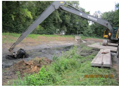
Durchführung der Beckenentschlammung
