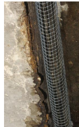
Nächtlicher Verschluss der Unterseite der Fuge mittels Drahtgeflecht in der Nacht vor dem Abriss
