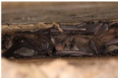
Wochenstubenkolonie in der Fuge zwischen den Richtungsfahrbahnen
