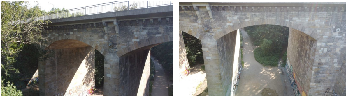
Bild 104 Drei Hauptbögen mit konstanter Bogendicke
