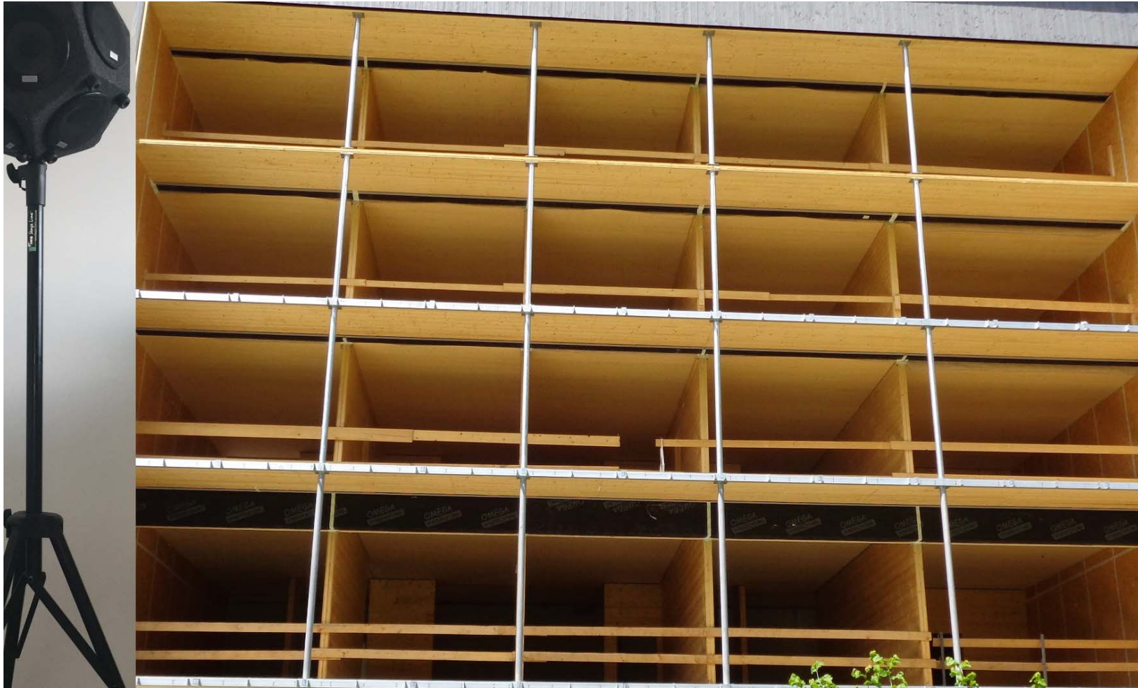
Bild: Holzbau Schafferer
