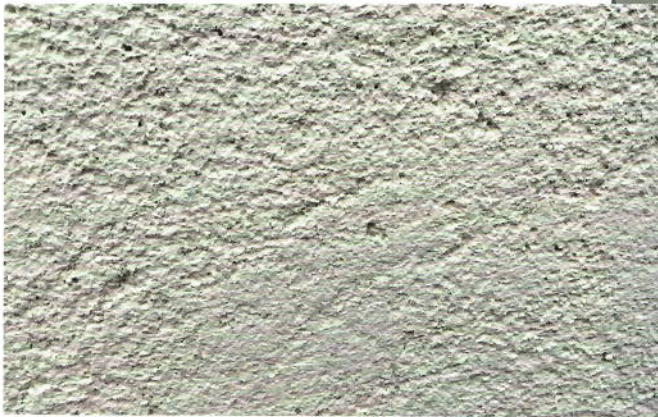
6 Detailansicht einer Glattstelle, die bei Betrachtung der gesamten Flächen störend auffallend ist.
