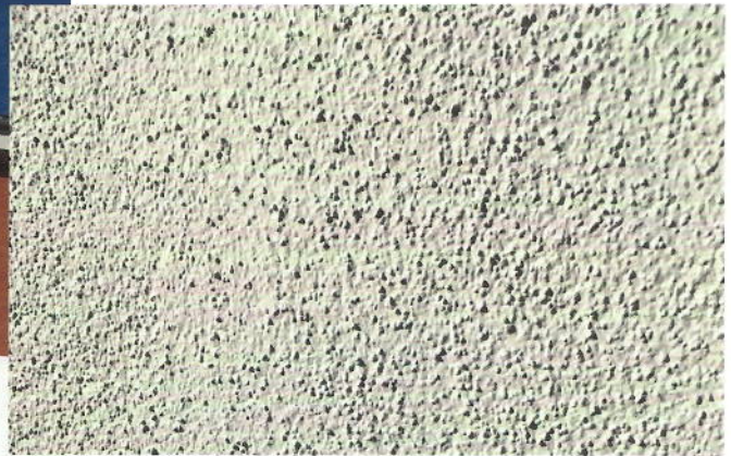
5 Detailaufnahme der gleichmäßigen Putzoberfläche. Die Struktur zeigt eine gute Gleichmäßigkeit.
