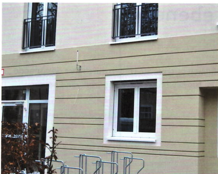
4 Abnahmereife Oberfläche. In der Betrachtung der gesamten Fläche sind keine störenden Flächen erkennbar.
