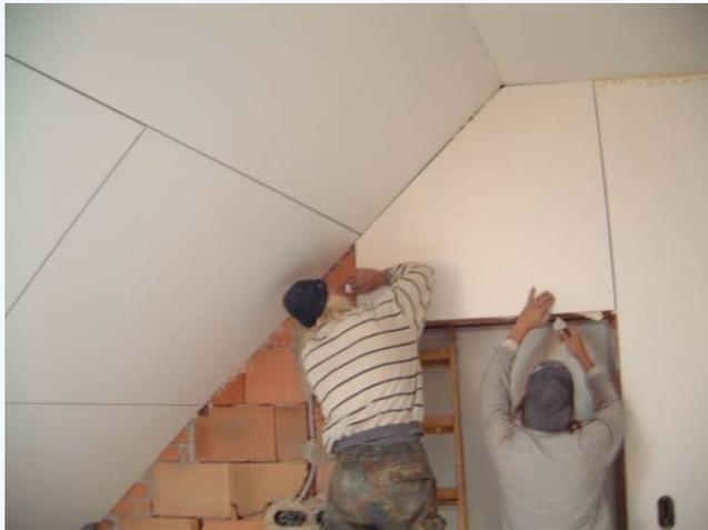
6. Dort wo die Metallkralle im Paneel steckt, wird nun ein 6 er Loch in die Mauer gebohrt ....
