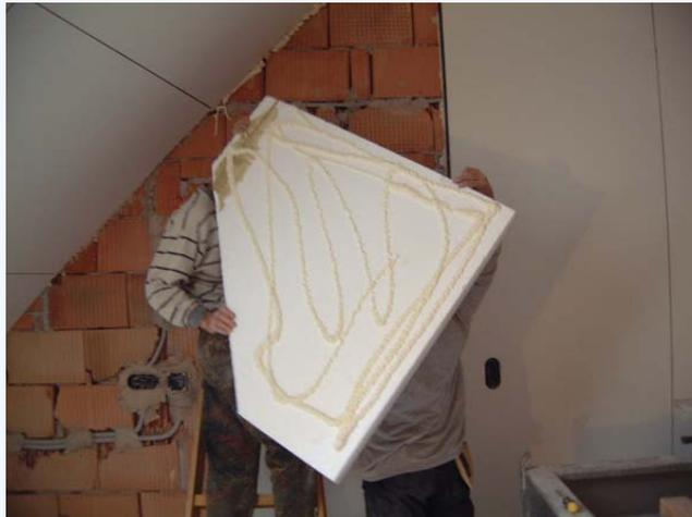
3. Als nächstes wird das Paneel mit seiner Nut auf die Feder des anderen Paneels aufgeschoben:
