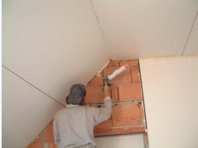
2. Jetzt wird auf die Rückseite der Platte schlangenförmig PU-Schaum aufgetragen:
