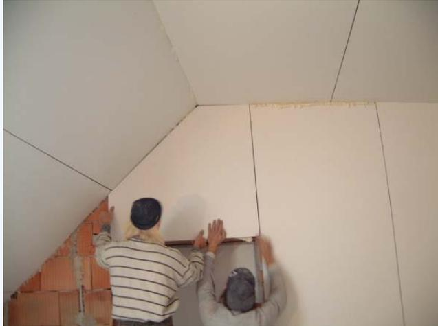
5. Nun werden in die 4 cm Isolierstärke des Paneels die Metallkrallen eingesteckt...
