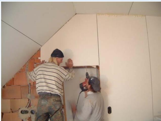
7. und anschließend werden die Krallen mittels Schlagdübel fixiert...
