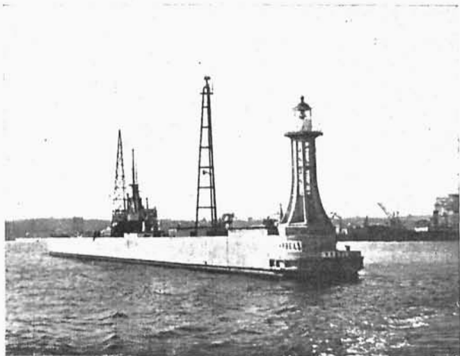
Ryc. 13. Stacja sygnalizacji w Gdyni przy głównym wejściu do portu.
