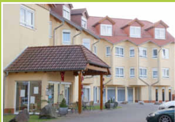
Erweiterungsbau (Teil mit den 3 Dachgauben rechts)
