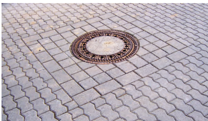
Bild 11: Fachlich und handwerklich gelungener Anschluss einer Pflasterdecke aus Verbundsteinen an einen Schachtdeckel mithilfe von Rechteck- und Sonderformsteinen Foto: SLG
