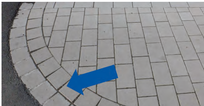
Bild 9: Keilfuge, die im Anschlussbereich der Pflasterdecke an eine Rundung entsteht Foto: SLG
