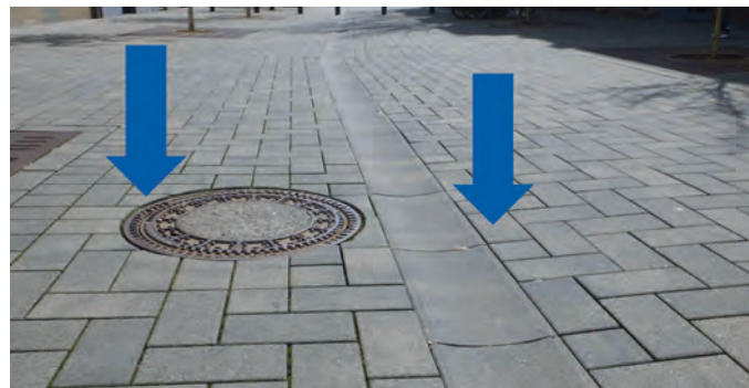
Bild 10: Die Oberfläche der Pflasterdecke muss an Einbauten und Entwässerungsrinnen überstehen Foto: SLG
